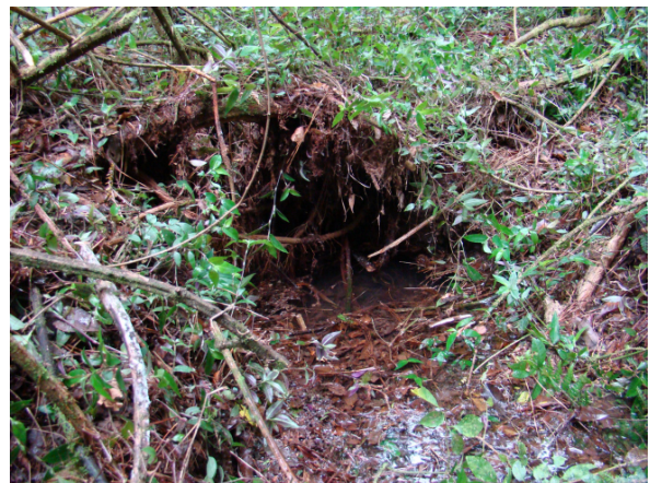
(d) pipe colapsado com \varnothing 30 cm e escoamento efêmero
