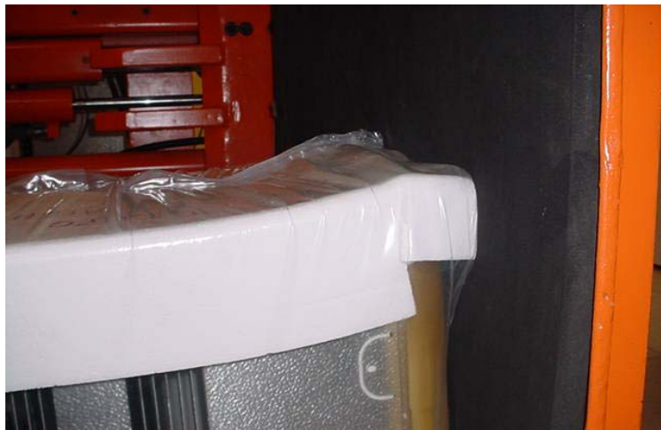
Figura 5.13 – Vista em detalhe deformação excessiva na região do tampo próximo ao painel
