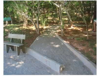
Figura 38: Rampa de acesso
