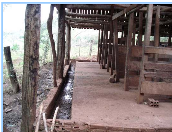
Figura 22 – Estrebaria em propriedade agrícola do município de Anchieta/SC que precisa ser fechada para ser adequada às normas de ordenha de vacas.
