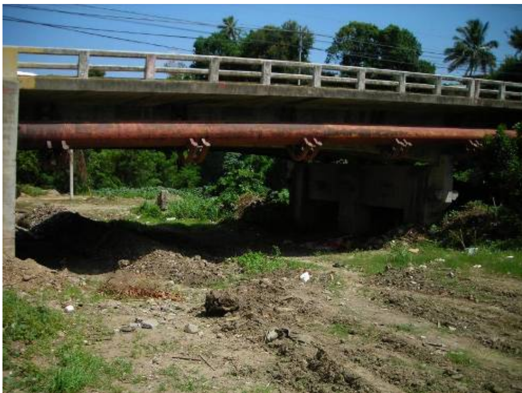
Figura 28 - Ponte na avenida Francia sobre o córrego Nibaje e passo da adutora (L-1) desde a ETA Nibaje-25 até os reservatórios La Zurza
