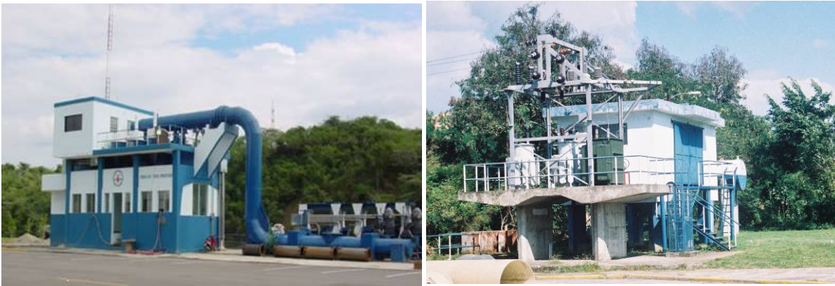
Figura 14 - Captação de Pastor, no rio Yaque del Norte e subestação elétrica com gerador de emergência, remodelada após o furacão David
