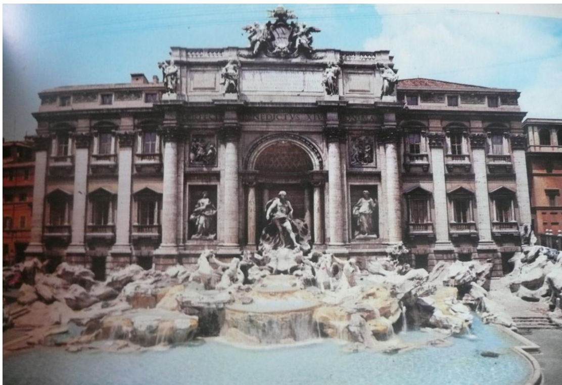
Figura 9 Fontana Di Trevi Impacto impressionante, no primeiro encontro com a Arquitetura Italiana de Roma. FONTE: PORTOGHESE (2001)
