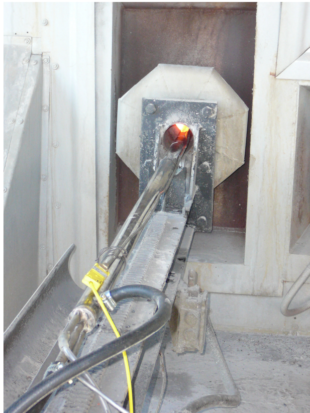
Figura 5.15 – Termosonda de imersão sendo instalada na unidade geradora de vapor.
