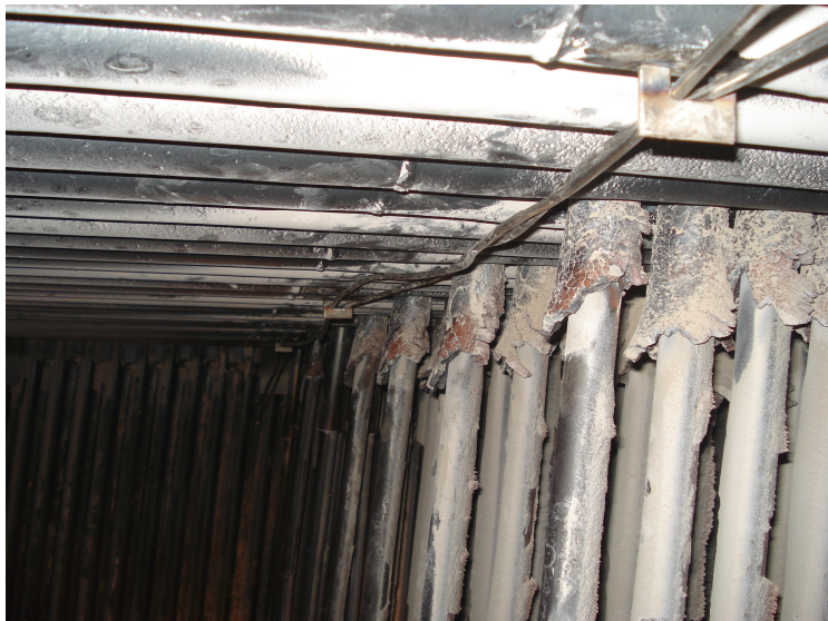
Figura 5.3 – Termopares fixados na parede d'água do teto da caldeira.
