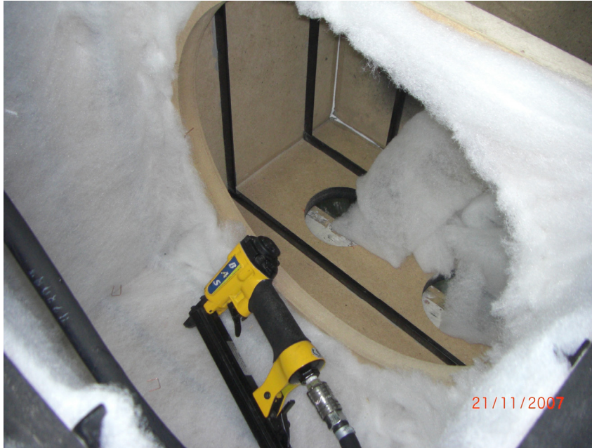
Figura 7.11 – Aplicação de manta de poliéster no interior das cavidades.
