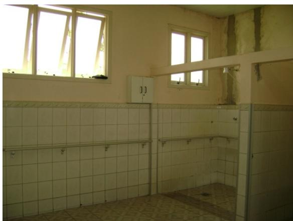
Fig. 40 – Barras de apoio junto ao boxe do banheiro feminino.
