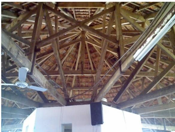
Fig. 61 – Estrutura do telhado do sombreiro.
