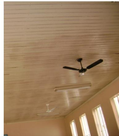
Fig. 34 – Forro da enfermaria feminina: em madeira pintada de branco, apresentado sinais de infiltração e mofo.
