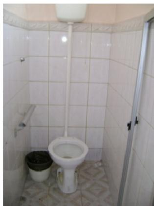
Fig. 53 – Cabine vaso sanitário enfermaria feminina: ausência de tampas dos vasos sanitários, barras laterais e porta destruída. Fonte: autora
