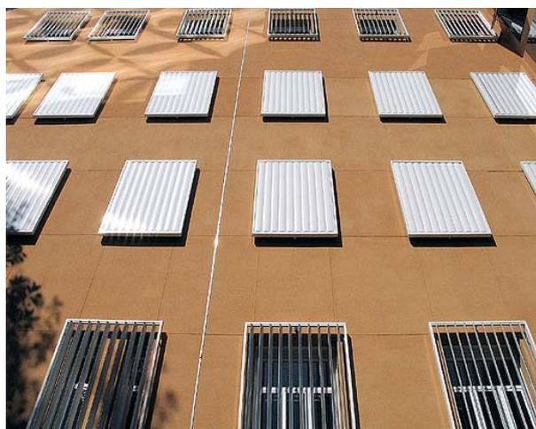
Fig. 81 – Parte externa da esquadria: emprego de brises verticais móveis.
