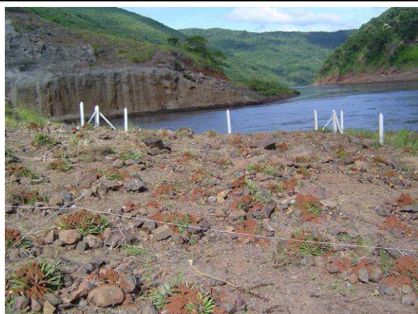
Relocação a jusante do lago da Usina Hidrelétrica Barra Grande (AR23), Pinhal da Serra – RS.
