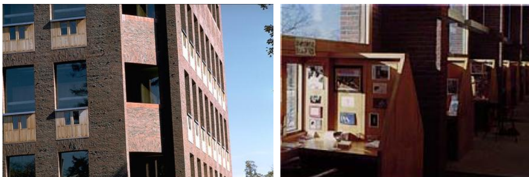
Figura 14 – Exemplo de abertura lateral, janela. Projeto de Louis Kahn, Phillips Exeter Academy Library (1966 - 1968) Fonte: Kidder-Smith (2006)
