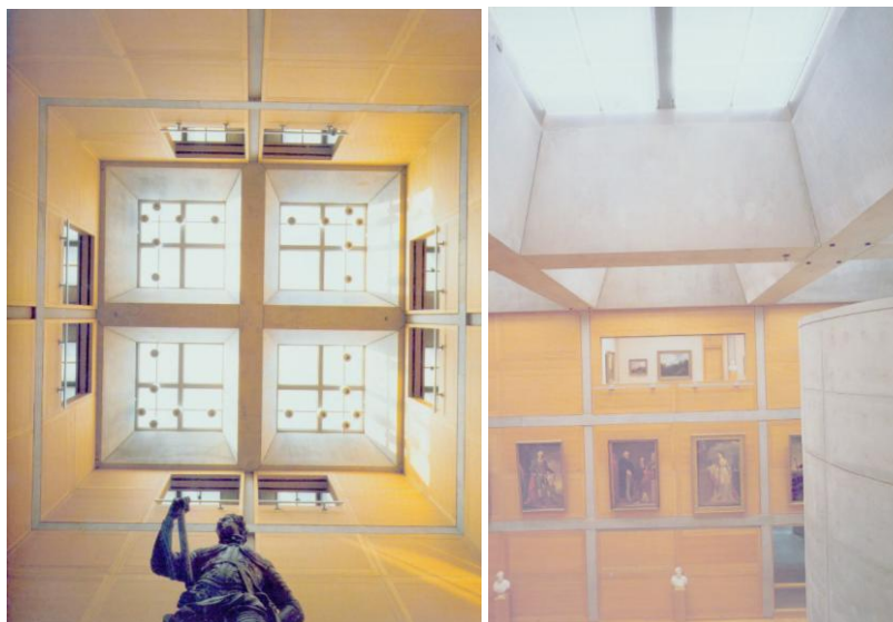
Figura 13 – Exemplo de abertura zenital. Projeto de Louis Kahn, Yale Art Gallery, Center for British Art - New Haven (1951 - 1953) Fonte: Brownlee e Long (1997)
