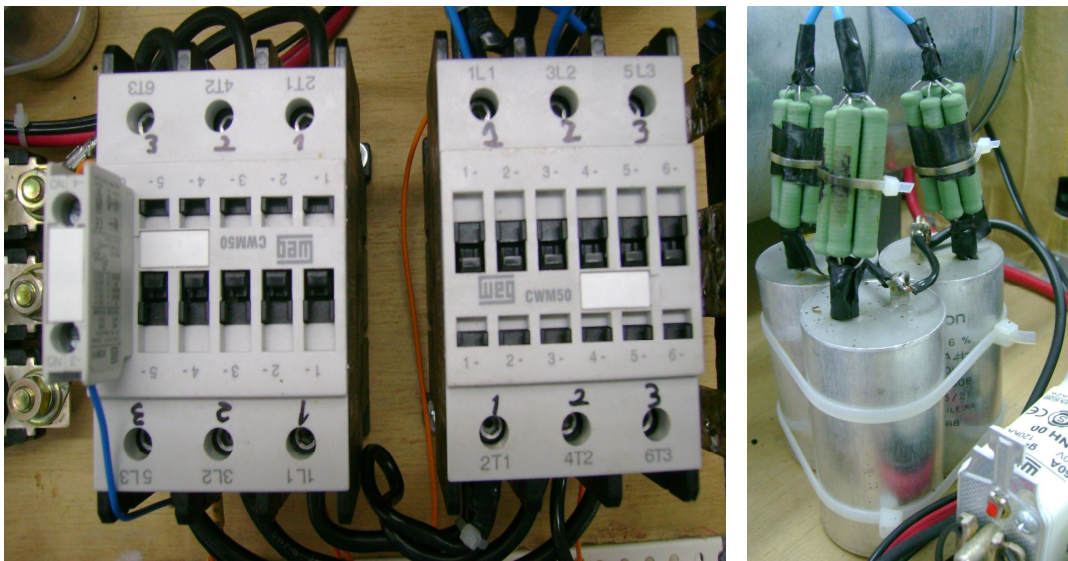
Fig. O.11 – Foto dos contatores (esquerda) e filtros RC (direita).
