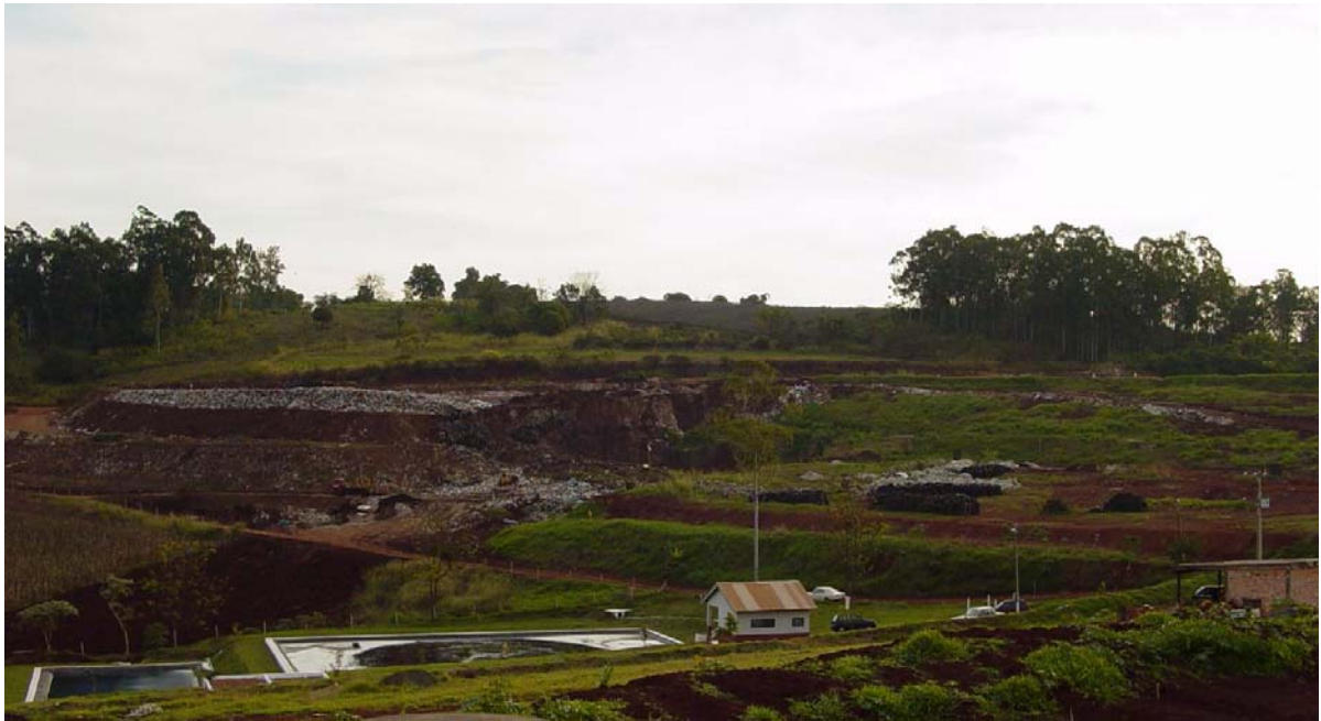
Figura 3.3.b - Vista geral do depósito de RSU de Londrina
