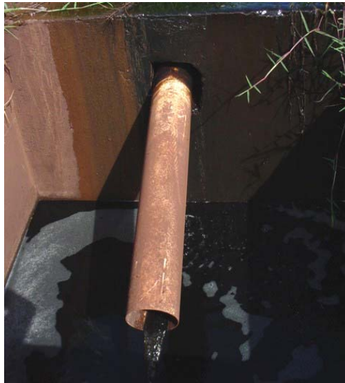
Figura 4.3 - Local de captação do lixiviado bruto do depósito de RSU de Londrina
