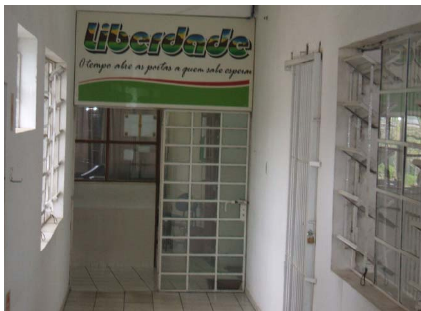
Foto 18 - Guarita de segurança e corredor de segurança
