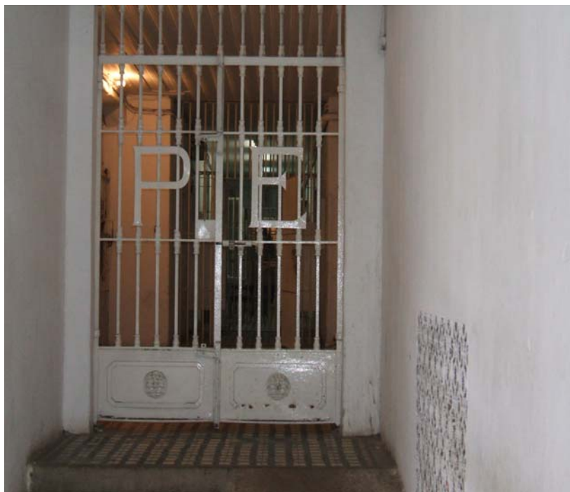
Foto 19 - Corredor para entrada na sala de visitas e celas.
