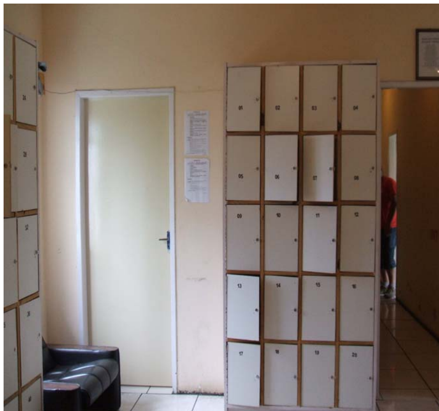
Foto 7 - Porta de acesso à sala de revista íntima, guarda-pertences e corredor para o detector de metais
