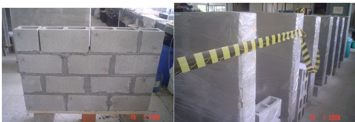
Foto 3.10 - Processo de fabricação e armazenamento das paredes
