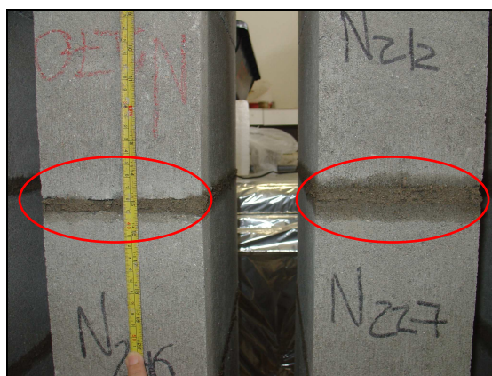
Figura 101. Diferença da altura de ascensão capilar no bloco de concreto (destacadas pelos círculos): prisma da esquerda moldado com argamassa de cimento com incorporador de ar mais retentor de água e prisma da direita moldado com argamassa de cimento apenas incorporador de ar.
