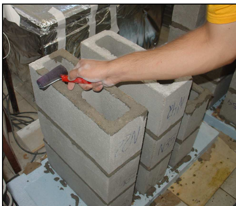
Figura 111. Procedimento de molhagem da face do bloco de concreto com a utilização de um rolo de pintura umedecido antes da colocação da argamassa.
