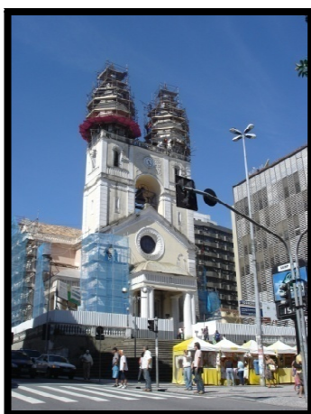
Ilustração 47. Obras de restauro na catedral
