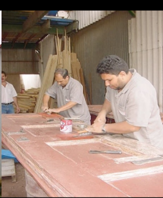
Figura 8. Restauração das aberturas
