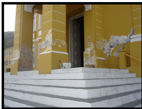
Ilustração 54. Consertos nas áreas degradadas
