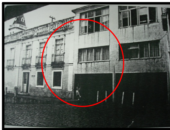
Ilustração 50. Anexo existente entre a Capela e o Hospital (Fachada Lateral sudoeste).
