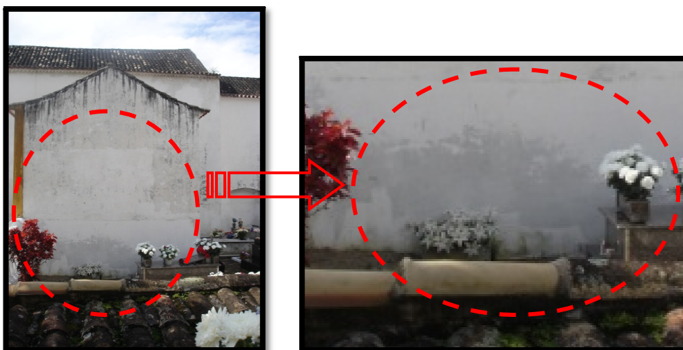
Ilustração 60. Fachada sudeste da Capela do Santíssimo ( Igreja N.S. das Necessidades)
