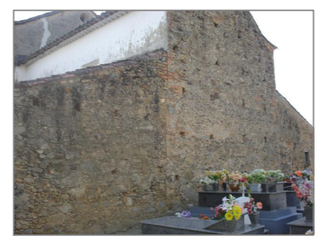
Foto fachada posterior leste Pombas Autors (2007)
