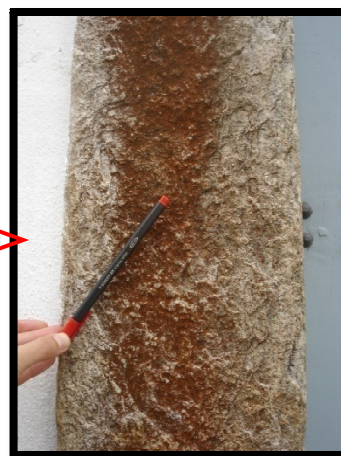
Ilustração 62. Detalhe da colônia de microorganismos
