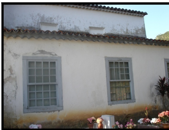
Ilustração 69. Setor da sacristia da fachada lateral Sul (Igreja N. S. da Lapa)
