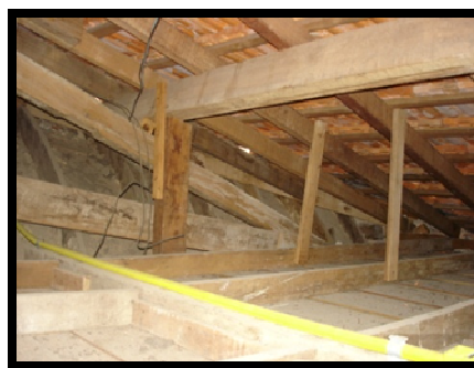
Ilustração 31. Detalhe da estrutura do telhado na área do museu sacro.
