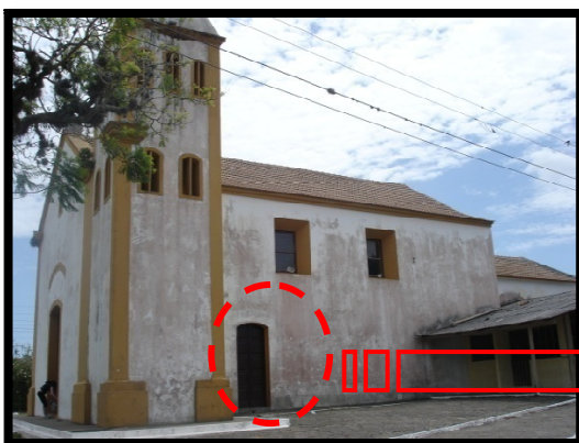
Ilustração 75. Fachada lateral sul (Capela de São João Batista)
