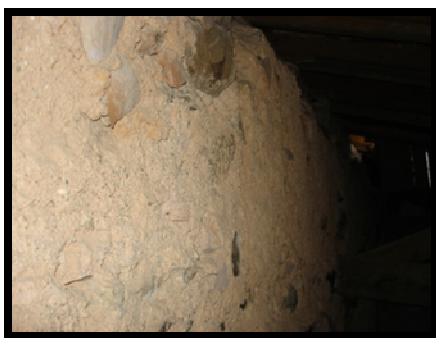
Ilustração 30. Parede interior perto do telhado que conserva a argamassa à vista.
