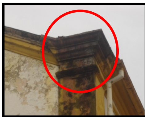
Ilustração 49. Detalhe da finalização da calha na fachada posterior.
