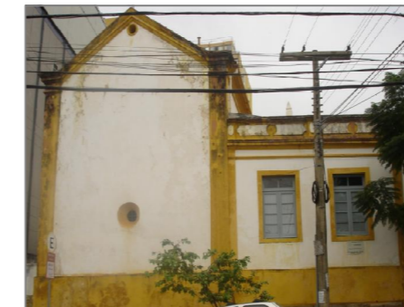
Foto fachada posterior nordeste Fonte: Autora (2006)
