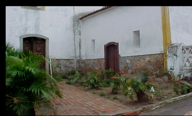
Figura 6. Substituição do reboco (Fachada lateral S.L)
