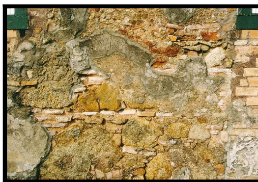
Ilustração 19. Disposição das pedras em edifício da Fortaleza de Santa Cruz
