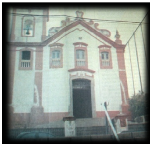
Ilustração 48. Fachada principal da Igreja Nossa Senhora do Rosário.
