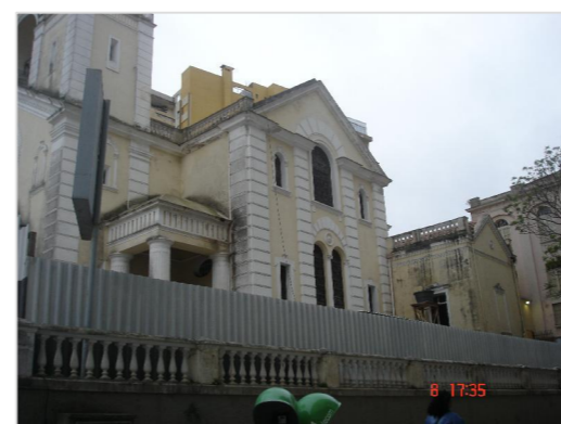
Foto fachada lateral leste Pontes: Autors (2007)
