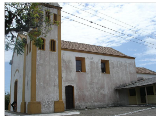
Foto fachada lateral sul Fonte: Autora (2007)
