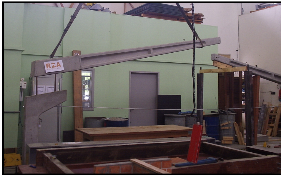
Figura 4.32 – Içamento da segunda viga a ser encaixada
