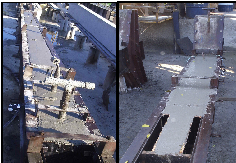
Figura 4.29 – Viga e pilar concretados
