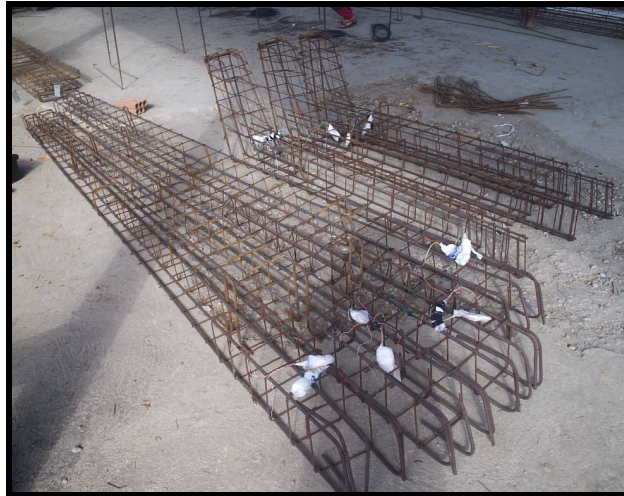
Figura 4.25 – Armaduras montadas e instrumentadas das peças do pórtico
