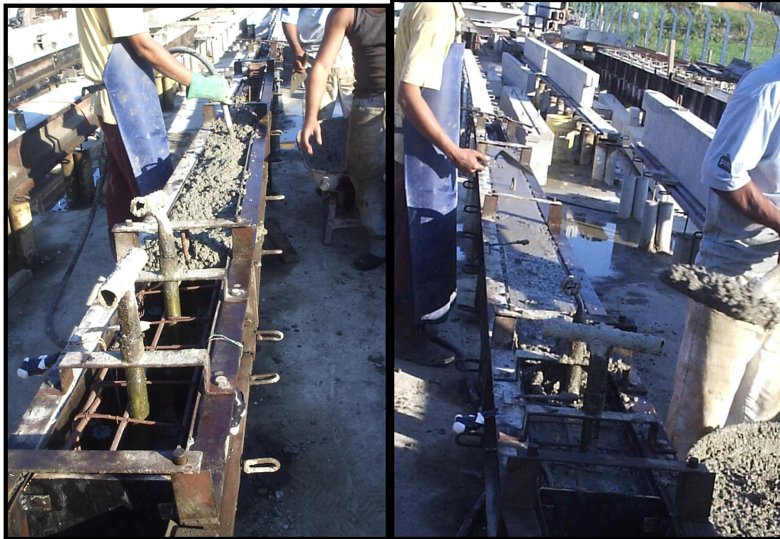
Figura 4.28 – Concretagem , vibração e adensamento da viga
