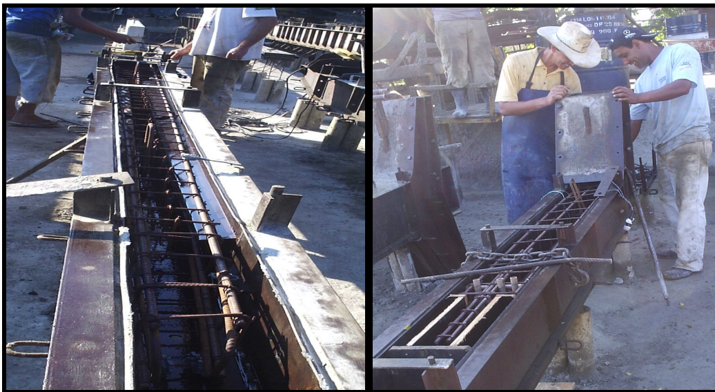
Figura 4.27 – Armaduras da viga e do pilar dentro das formas metálicas
