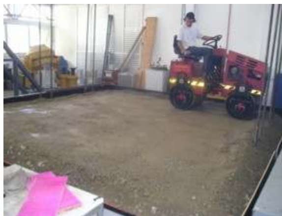
Figura 6.15 Compactação da base.
