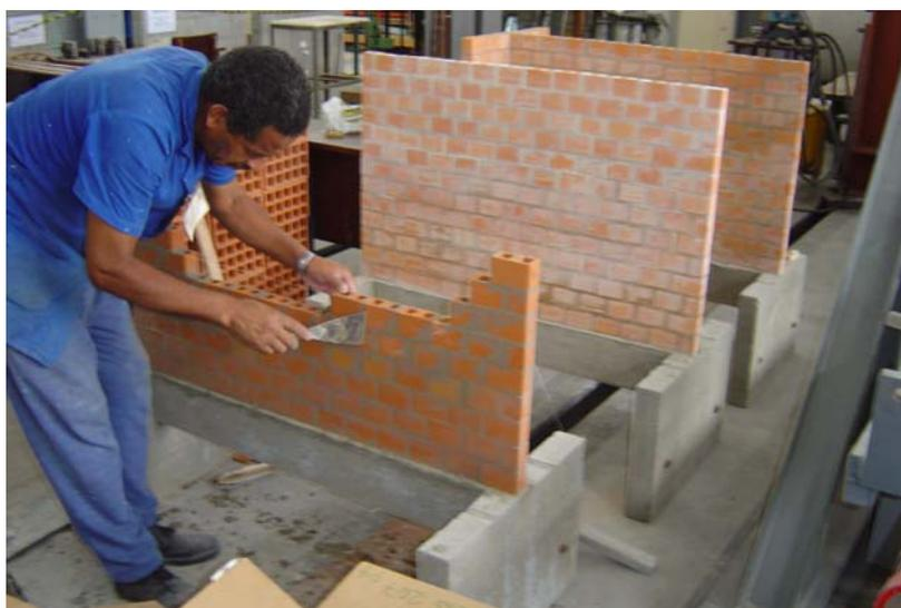
**Figura 5.26 – Execução da alvenaria (LEE) – protótipos 1 e 2 prontos e o 3 em execução.**
