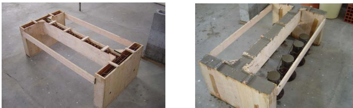
**Figura 5.24 – Base de concreto a) forma com a armadura e, b) após a concretagem.**
