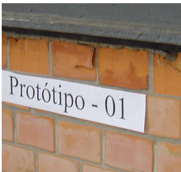
**Figura 5.31 –Detalhe do desfolhamento dos blocos devido à ação do neoprene.**
