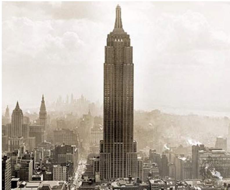
Figura 2.8 – No centro da figura a edificação mais alta é o Empire State Building (ENCYCLOPEDIA BRITANNICA, 2007).
