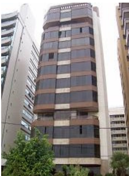
Figura 5.3 – Edificação multifamiliar construída em 1984. Sacadas por toda a fachada, revestimento cerâmico e vidro fumê .
