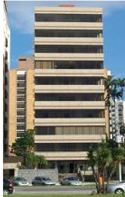
Figura 5.6 – Edificação multifamiliar construída em 1972. Foi reformada nos anos 90 e recebeu fechamento da sacada.
