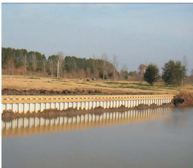
Figura 1.3: Perfis em PVC utilizados para a construção de ilhas artificiais - "Sheet piling".
