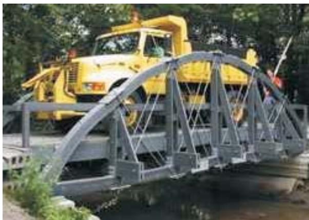
Figura 1.2: Ponte sobre o rio Hudson construída com plástico reforçado com fibra de vidro (Krishnawamy, 2001).
