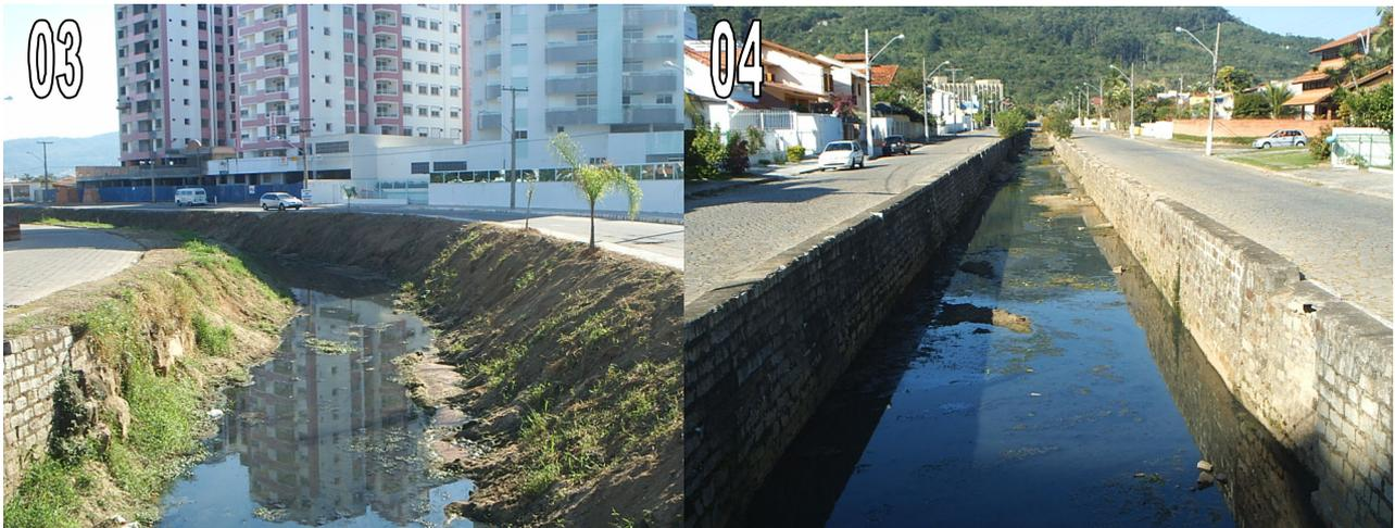
Figura (12) - Fotos (03 e 04) – Canal retificado na bacia hidrográfica do Rio Itacorubi.
