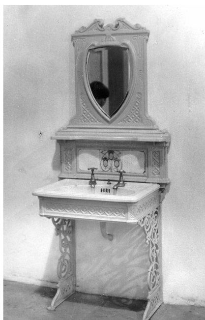
Figura 2 – Fotografia P&B de uma pia recém instalada no atual Palácio Cruz e Sousa (Florianópolis) na década de 1910. (IHGSC)
