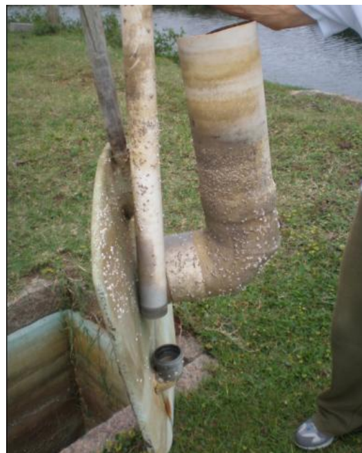
Figuras 6.3 e 6.4 – Tampa de vedação - detalhes dos canos de despressurização (menor diâmetro) e de escoamento (maior diâmetro)
