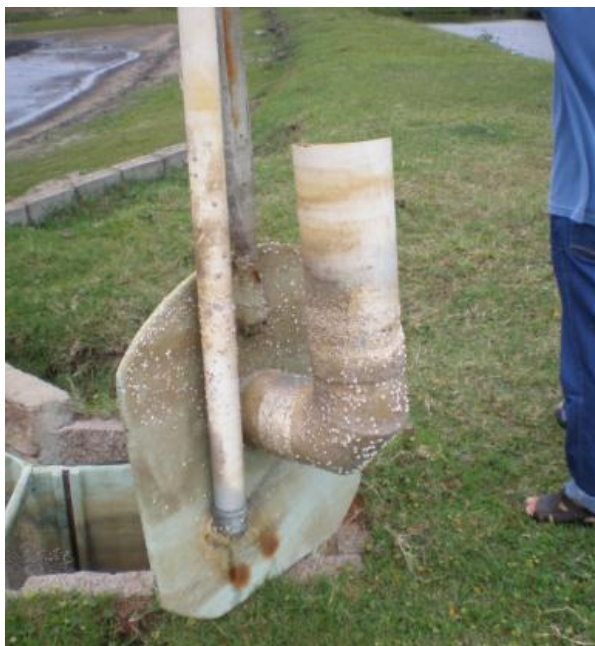
Figuras 6.3 e 6.4 – Tampa de vedação - detalhes dos canos de despressurização (menor diâmetro) e de escoamento (maior diâmetro)
