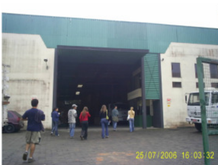
Figura 13: Fachada do Galpão da Almeida Comércio de Papéis
