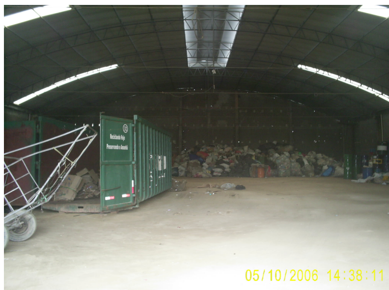
Figura 38: Imagem Interna de Galpão Filial da Só Papel em Palhoça/SC
