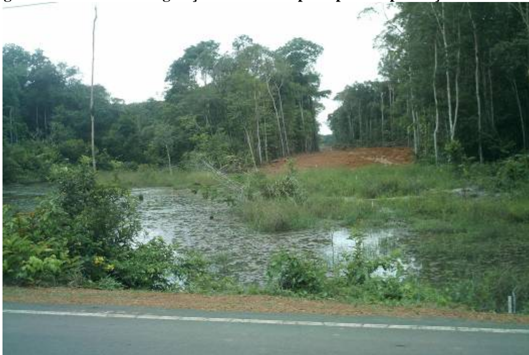
Figura 11 – O corte de vegetação em Manacapuru para implantação do Gasoduto
