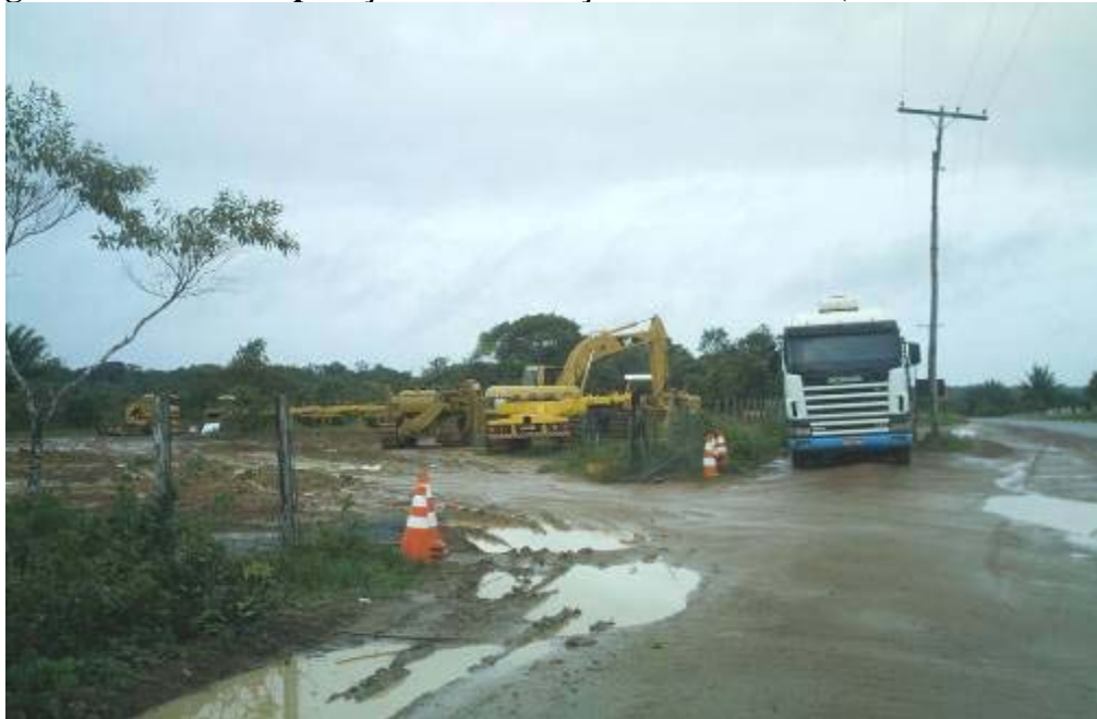
Figura 41 – Base de operação da construção do Gasoduto (km 4 – Novo Airão)
