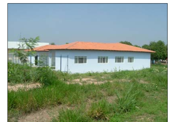
Figura 13: Vista Lat. Esquerda (V4)
