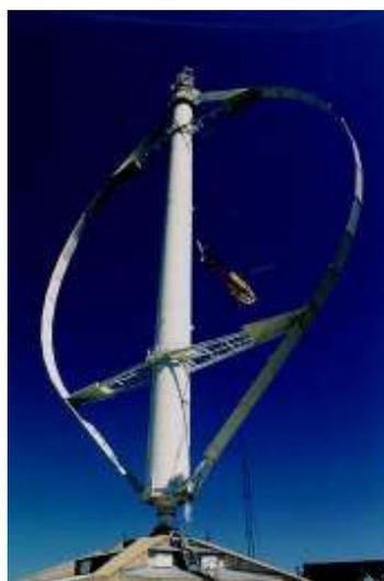
Figura 3.12. Aerogerador Eole C. 4,2 MW.
