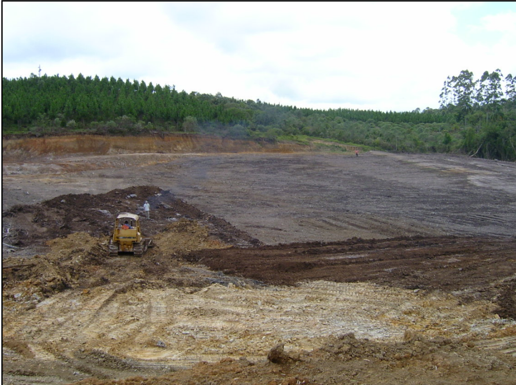
Foto 7 – Reafeiçoamento topográfico da área de pesquisa executado com trator tipo D-6 – 2003
