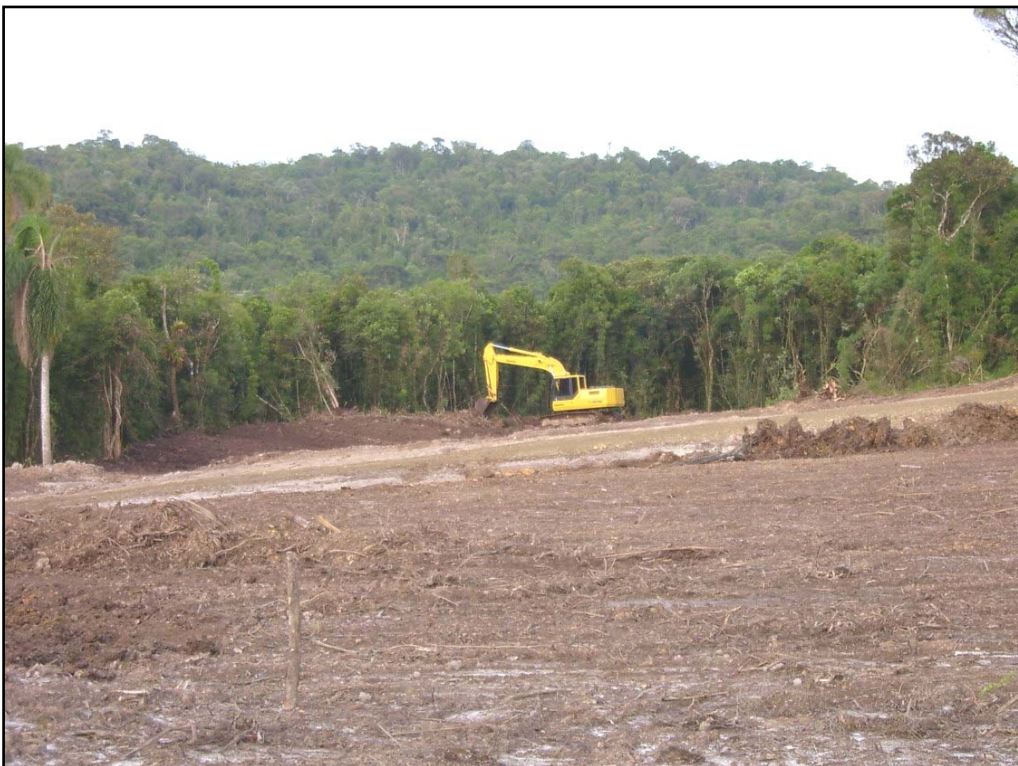
Foto 8 – Coleta do solo orgânico e serapilheira em área vizinha da pesquisa com escavadeira hidráulica – 2003
