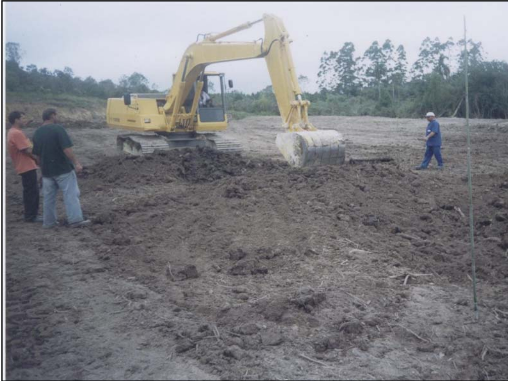
Foto 11 – Preparação das rugosidades com escavadeira hidráulica – 2003
