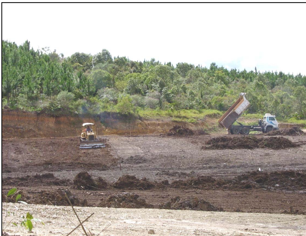
Foto 10 – Espalhamento do solo e serapilheira com trator tipo D-6 – 2003
