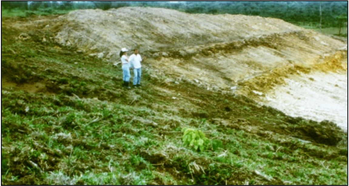
Foto 2 – Terraceamento com taludes e bermas criando superfícies planas e mais regulares em área de mineração de Campo Formoso, no município de Doutor Pedrinho, SC – 1995
