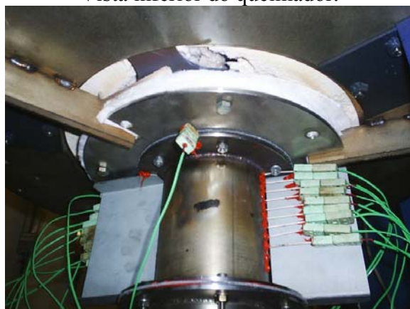
Montagem do queimador na fornalha.
