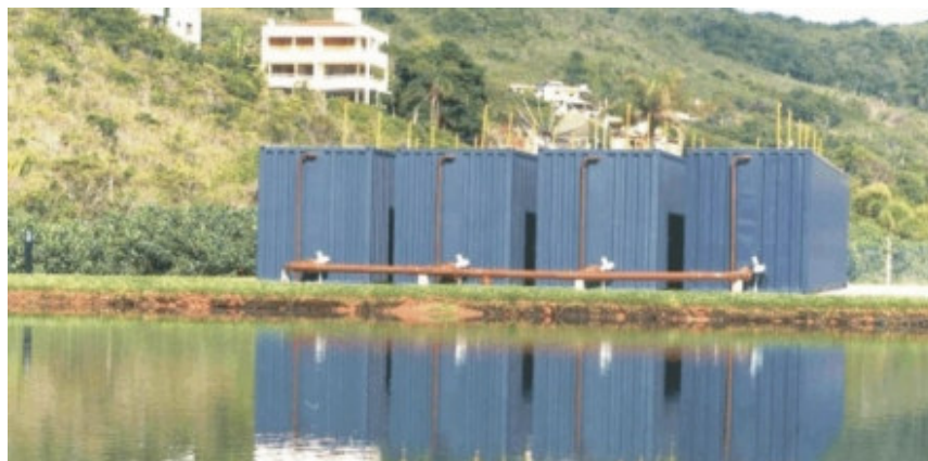
Figura 16 – Estação de Tratamento de Esgotos da Praia Brava.
