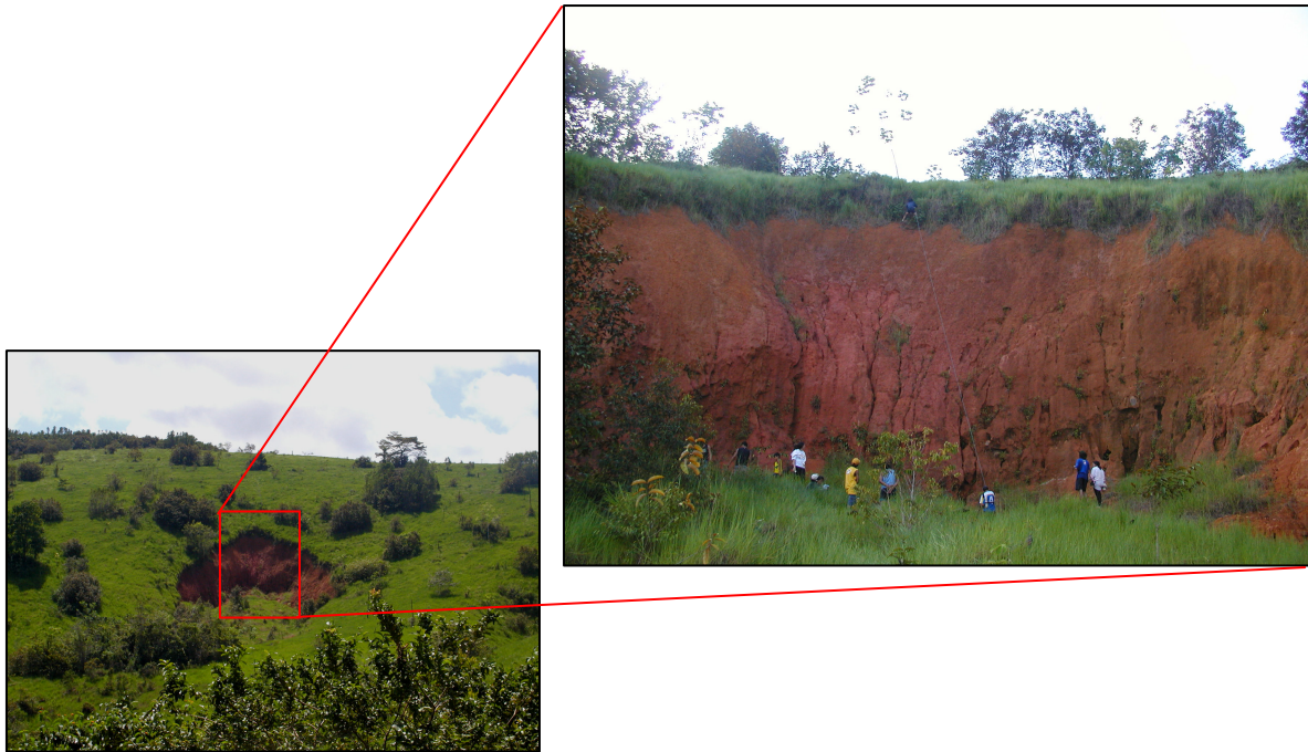
FIGURA 02 – Cicatriz (C1): o quadrado em vermelho destaca a superfície de arranque (parede).
