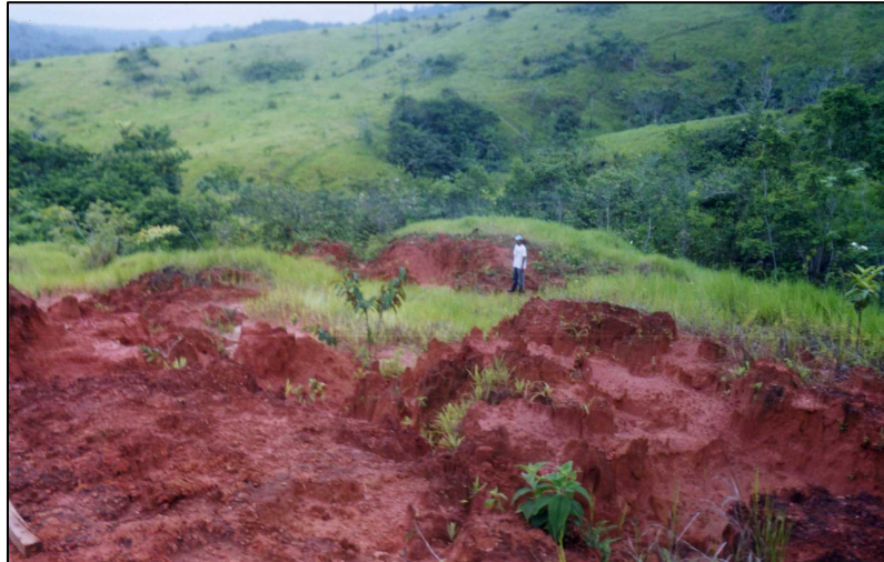
FIGURA 48 – Massa movimentada – base do escorregamento rotacional
