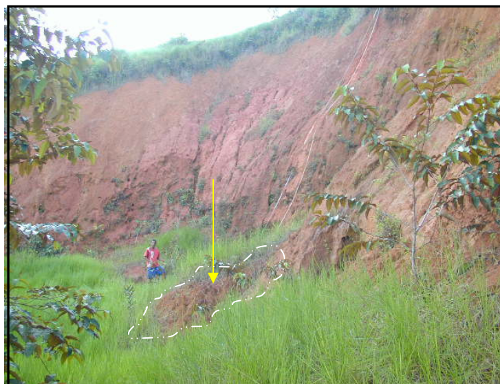
FIGURA 34 – Depósito de material na base da parede – escorregamento em cunha
