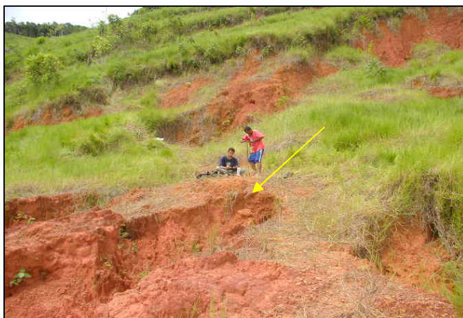
FIGURA 31 – A seta sinaliza voçoroca na massa movimentada - cicatriz (C2)
