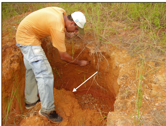
FIGURA 54 – Alcova e material desmoronado no fundo da voç01
