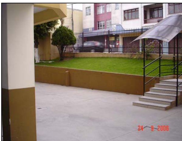
Figura 70 - Registro da diferença de nível do terreno à rua.
