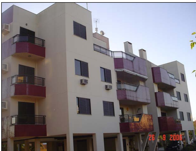
Figura 85 - Foto da fachada frontal (entrada) do edifício Ingleses
