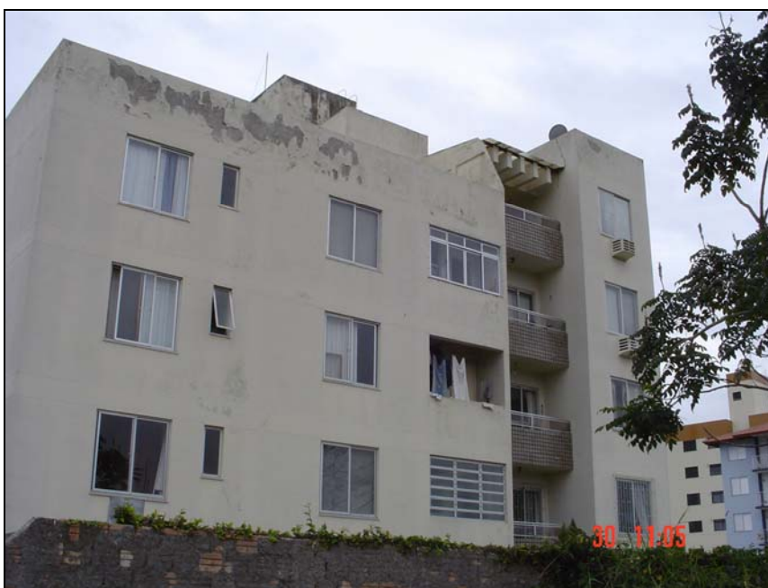
Figura 42 - Vista da fachada Nordeste
