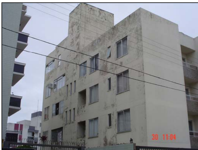
Figura 49 – Vista da fachada oeste e sul
