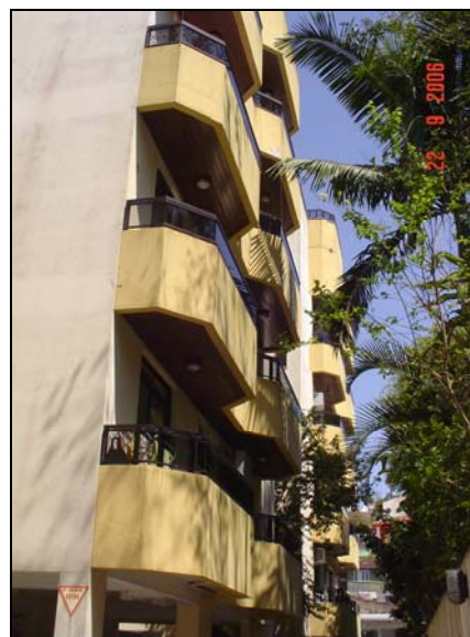
Figura 71 - Vegetação vizinha muito próxima a fachada Oeste.
