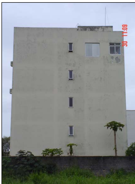
Figura 43 - Foto da fachada Noroeste
