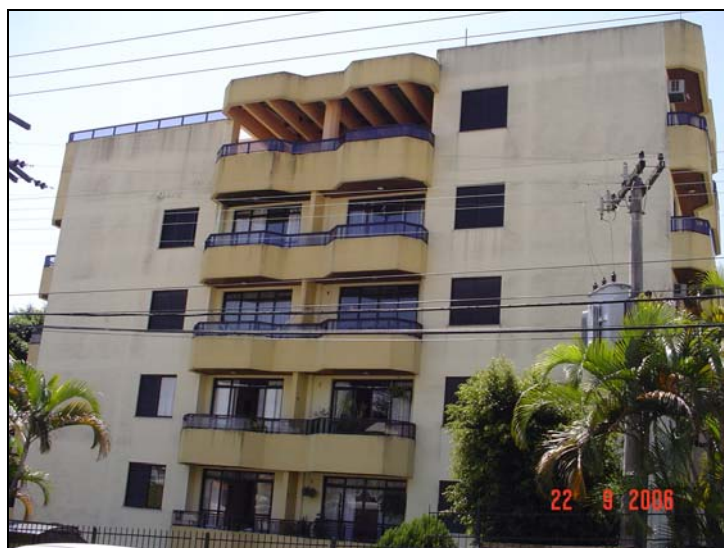
Figura 67 - Foto da fachada sudoeste do edifício Estreito
