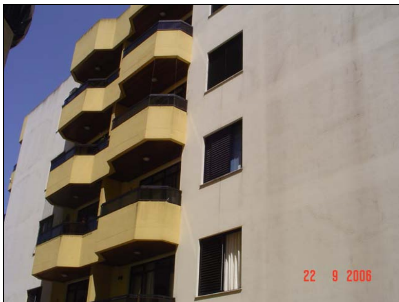
Figura 74 - Registro dos volumes provocados pelas sacadas em balanço na fachada Leste.
