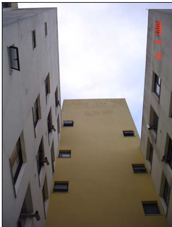
Figura 76 - Torre da escadaria e do reservatório superior
