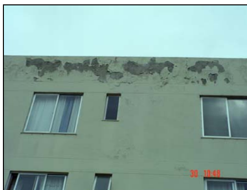
Figura 61 - Decomposição pontual do RAF da platibanda da fachada nordeste
