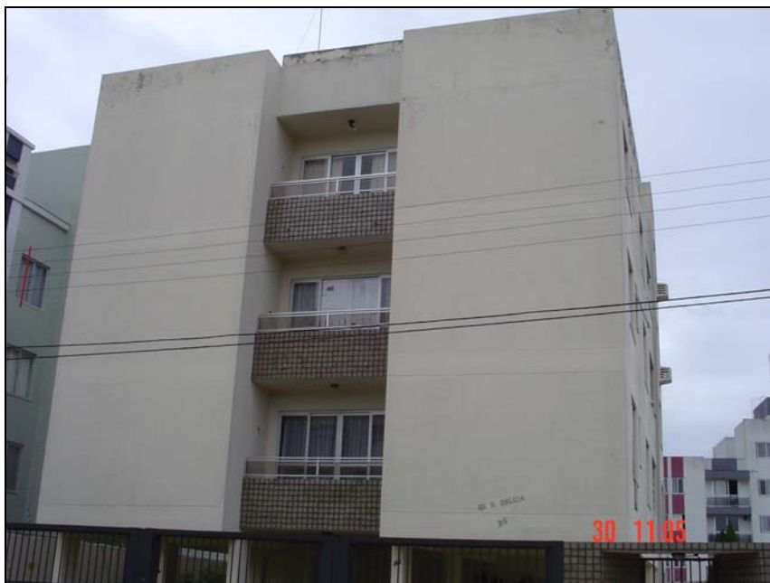
Figura 41 - Vista da fachada Sudeste
