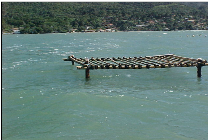
Figura 122 - Estrutura fixa abandonada na região da Baía Sul, SC Fonte: CEPSUL/IBAMA (2005)
