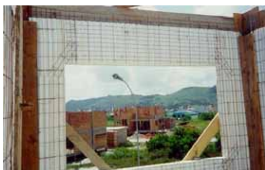
Figura 5.17 – Colocação das armaduras de reforço
