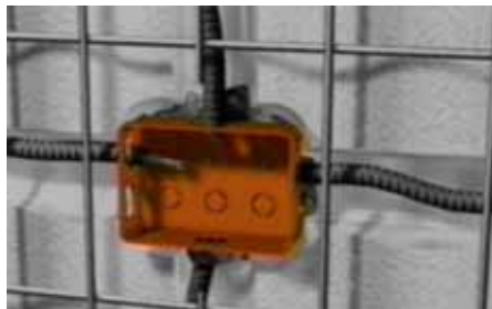
Figura 3.29a – Colocação da caixa de passagem no painel
