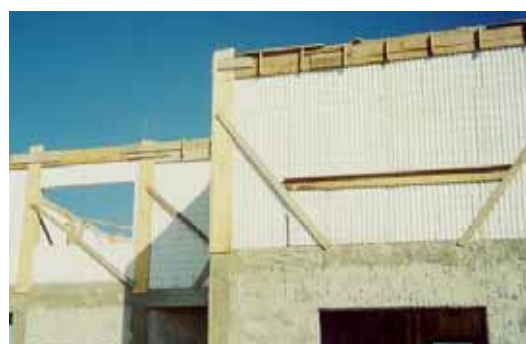
Figura 5.18 – Continuação da montagem e travamento
