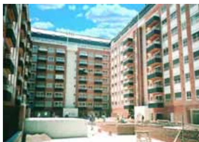
Figura 2.27 – Obra com painéis - Puerto Madero
