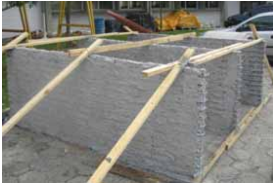
Figura 4.9 – Execução revestimento dos painéis a serem ensaiados - 1ª. demão de argamassa.
