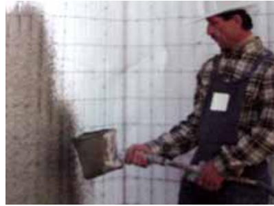
Figura 3.31 – Projeção de argamassa em painel
