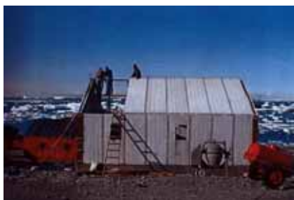
Figura 2.23 – Obra com painéis - Base / Antártida
