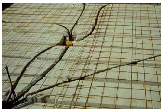
Figura 5.15 – Instalações elétricas
