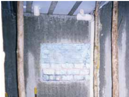
Figura 5.48 – Laje de piso (pré-moldada com eps)
