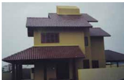
Figura 5.23 – Obra concluída - Fachada Sul
