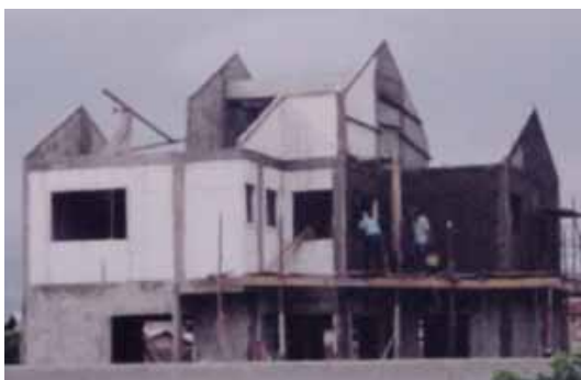
Figura 5.19 – Painéis de fechamento da cobertura
