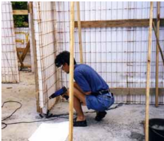
Figura 5.42 – Execução de sulcos nos painéis para receber as instalações.
