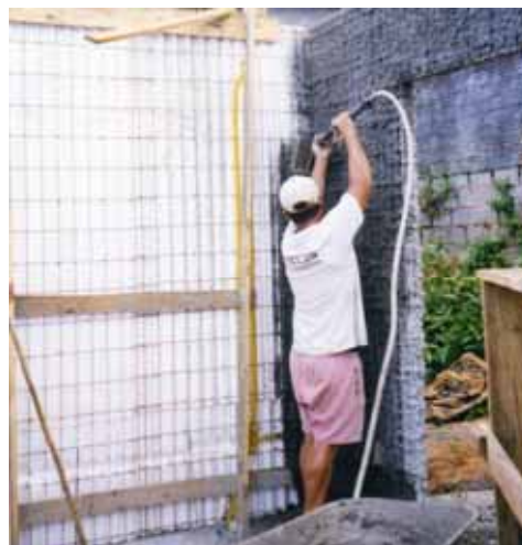
Figura 5.45 – Projeção de argamassa no painel com caneca de projeção pneumática.
