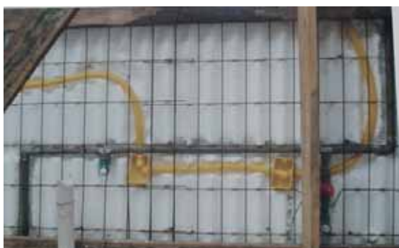
Figura 5.13 - Instalações hidráulicas e elétricas
