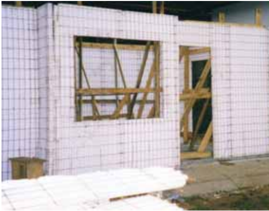
Figura 5.40 – Alinhamento e travamento painéis
