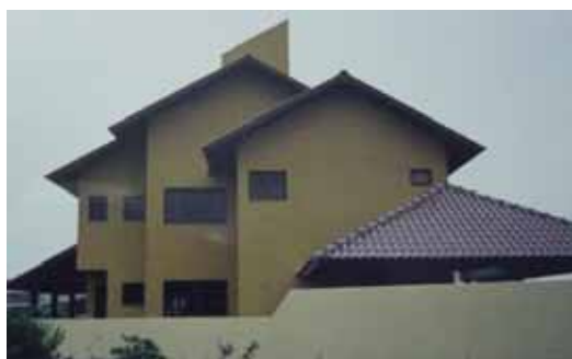
Figura 5.24 – Obra concluída - Fachada Leste
