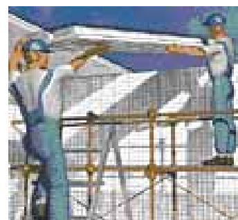
Figura 3.17 – Montagem Painel Laje
