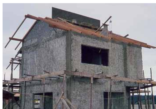
Figura 5.22 – Construção do madeiramento do telhado
