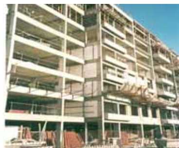
Figura 2.26 - Painéis de vedação- Puerto Madero
