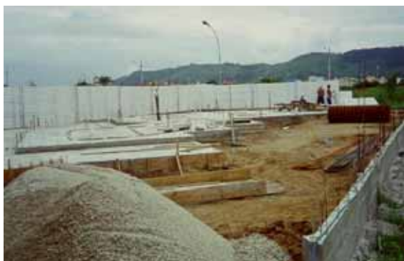
Figura 5.9 – Montagem - painéis muro
