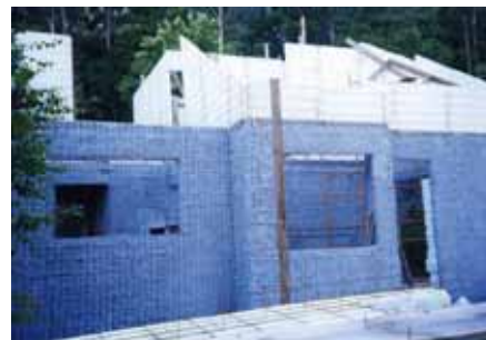
Figura 5.51 – Continuidade painéis paredes
