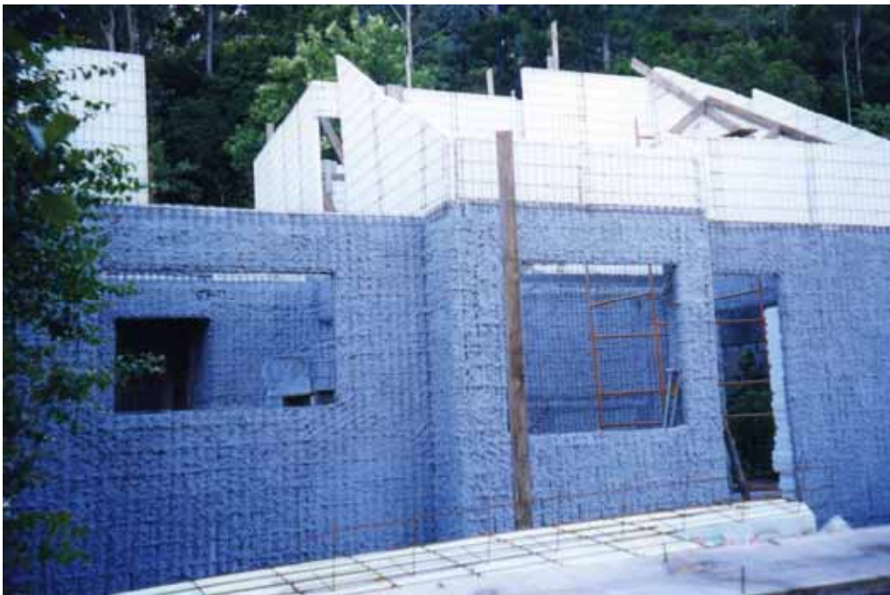
Figura 5.35 – Fachada com revestimento pavimento térreo com argamassa projetada – 1ª. demão e painéis montados pavimento superior.
