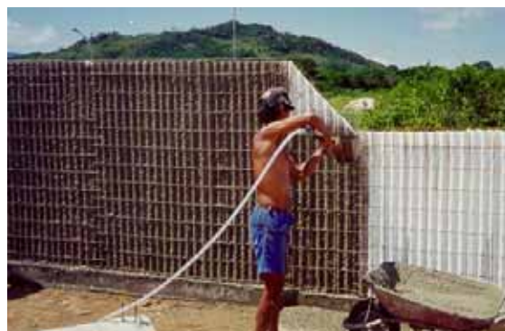
Figura 5.10 – Projeção 1ª. Demão de Argamassa
