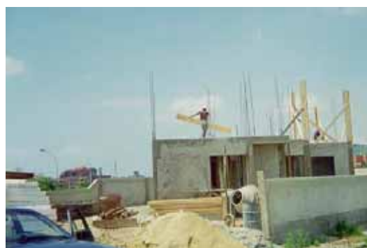
Figura 5.16 – Início da montagem segundo pavto.
