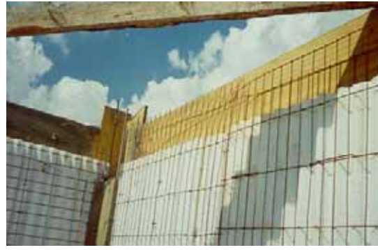
Figura 5.28 – Telas dos painéis incorporados as vigas
