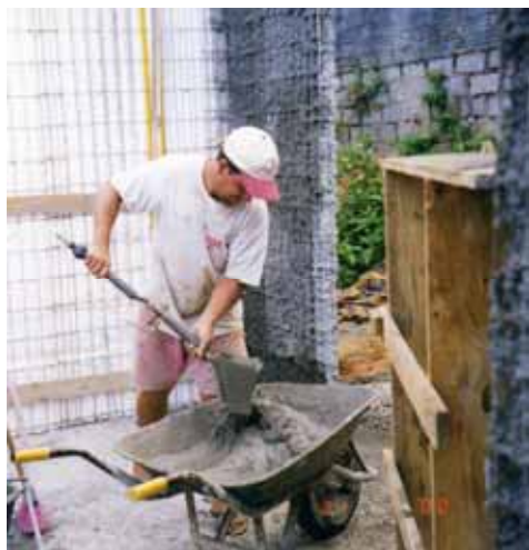
Figura 5.44 – Operário recolhendo argamassa com a caneca de projeção pneumática.
