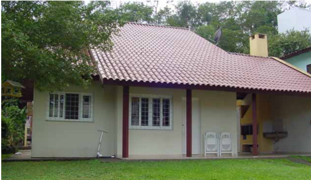
Figura 5.29 – Estudo de Caso 2 - Vista obra concluída
