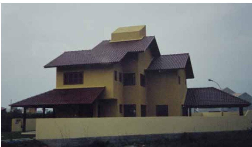
Figura 5.1 – Estudo de caso 1 - Vista obra concluída
