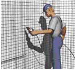
Figura 3.26 – Execução de sulcos para instalações nos painéis
