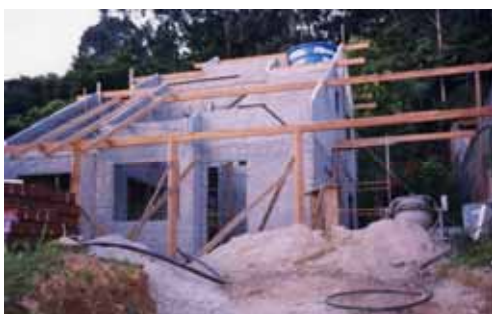
Figura 5.52 – Madeiramento da cobertura
