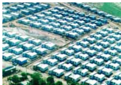
Figura 2.24 – Obra com painéis - Venezuela
