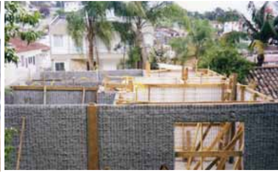
Figura 5.47 – Argamassamento dos painéis/térreo
