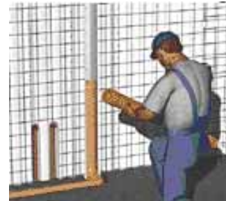
Figura 3.28 – Execução de instalações hidráulicas nos painéis
