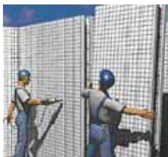
Figura 3.15 – Montagem Painel Parede Duplo
