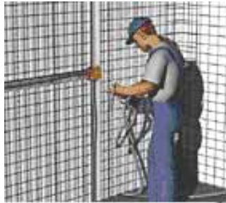
Figura 3.27 – Execução de instalações elétricas nos painéis
