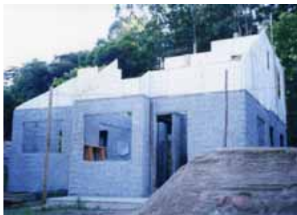
Figura 5.50 – Montagem painéis pavto. superior
