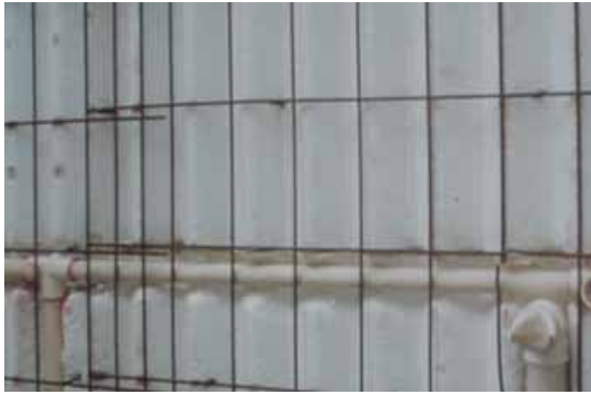
Figura 5.27 – Transpasse de talas dos painéis
