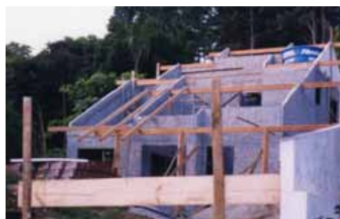
Figura 5.53 – Madeiramento da cobertura
