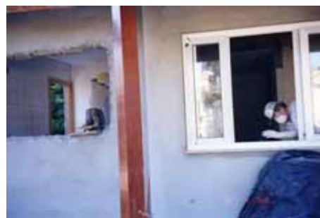
Figura 5.55 – Preparo para pintura
