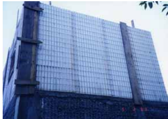
Figura 5.49 – Montagem pavimento superior
