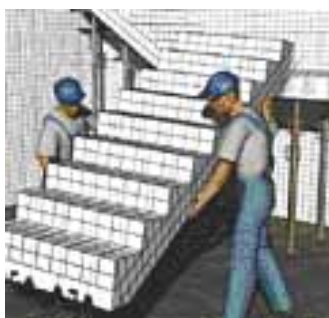
Figura 3.16 – Montagem Painel Escada
