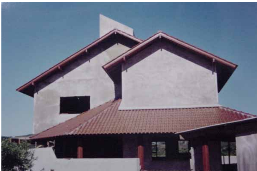
Figura 5.8 – Fachada com painéis revestidos com argamassa projetada.
