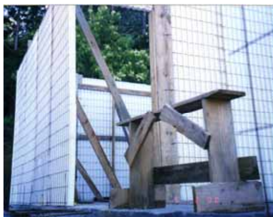
Figura 5.39 – Montagem painéis e transpasse de telas e ancoragem com o piso
