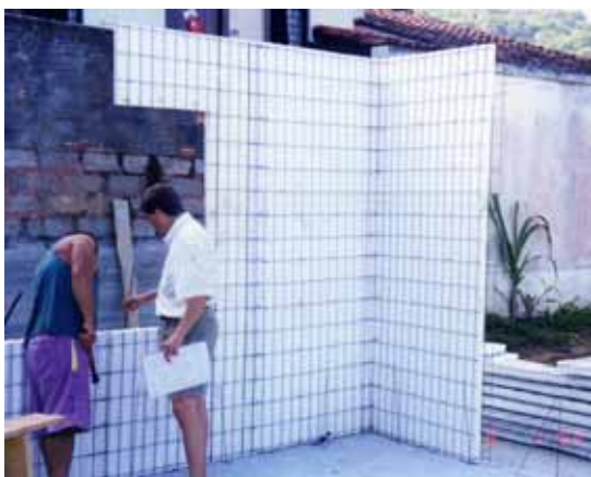
Figura 5.38 – Início da montagem no encontro de paredes, canto da sala.
