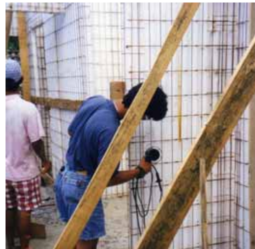
Figura 5.43 – Execução de sulcos nos painéis para receber as instalações
