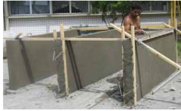
Figura 4.10 – Execução revestimento dos painéis a serem ensaiados - 2ª. demão de argamassa.
