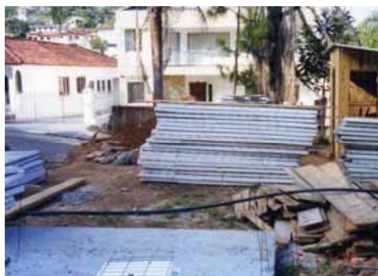
Figura 5.37 – Contra piso, ferragem de ancoragem e painéis estocados para montagem das paredes.
