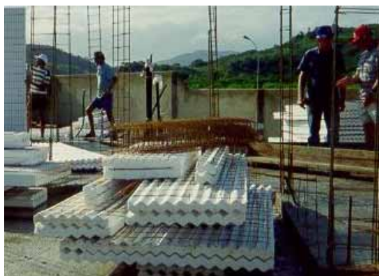
Figura 5.11 – Montagem - Pavto. Térreo
