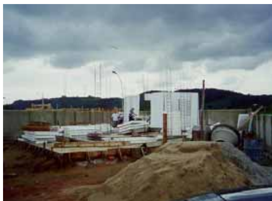
Figura 5.12 – Início das montagens Pavto. Térreo
