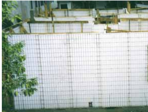
Figura 5.41 – Montagem pavimento térreo
