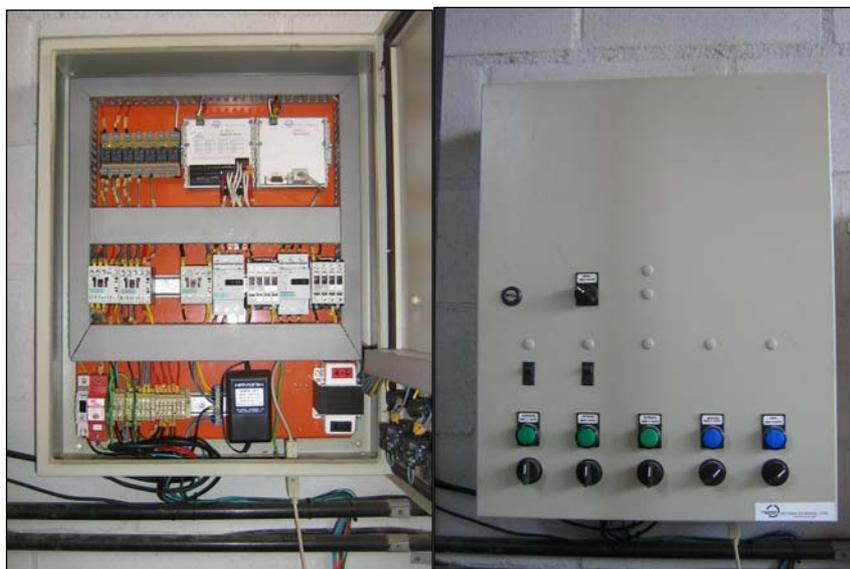
Figura 4.8 – Foto do interior e da frente do painel de controle
