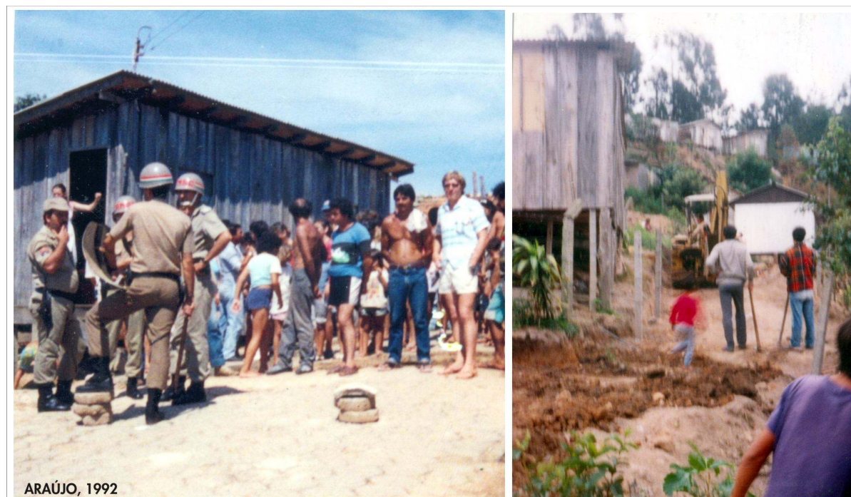
Figura 17 – À esquerda, foto durante a execução da ação de despejo. À direita, as primeiras obras de calçamento na Serrinha
