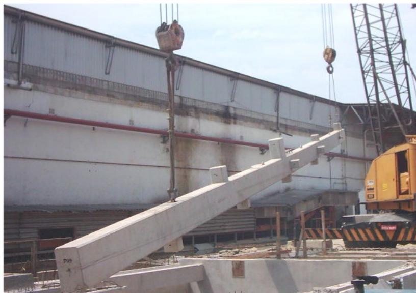
Figura 1.1 – Montagem de pilar pré-moldado (0,3x0,6x24m) em idades iniciais
