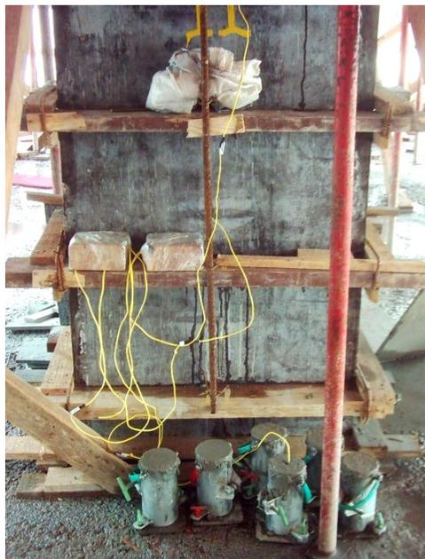
*Figura 4.11 – Corpos-de-prova cilíndricos e pilar durante a concretagem*
