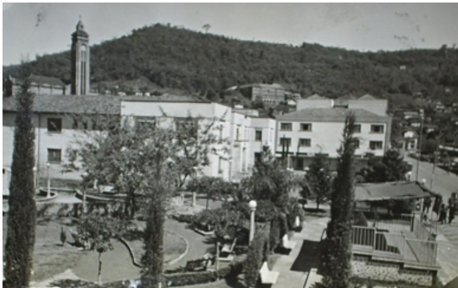
FIGURA 11 - Praça Adolfo Konder e Prefeitura Municipal na Avenida XV de Novembro com Igreja Matriz ao fundo - 1960
