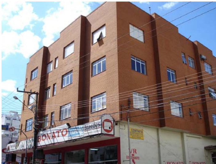
FIGURA 17 – Loja de materiais de construção Bonato no centro de Joaçaba.
