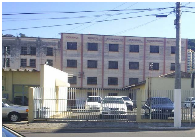
FIGURA 20 – Prédios do parque fabril da empresa Romano Massignan S/A Ind. Com. A Concessionária de veículos está localizada no lado esquerdo dos prédios abandonados.
