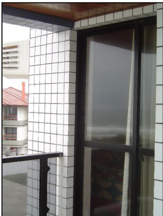
Foto – detalhe das aberturas em alumínio e vidro sem a presença de venezianas, porem com sistema de fechamento contra ventos e infiltrações.
