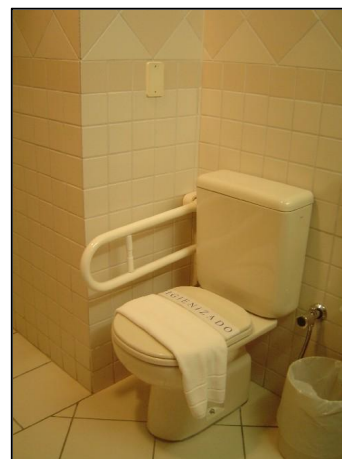
Fotos – BWC em uma UH adaptada para portadores de deficiência sem parte de exigências da NBR 9.050/04 e BWC Social com porta de 90 cm de largura mas também com problemas de adaptação.
