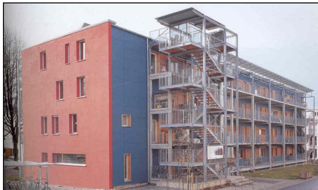
Foto 05: Selo Casa Passiva - Ed. Habitat e Trabalho – Friburgo de Brisgovia Arqs. Common Gies
