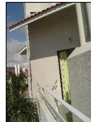
Foto – coberturas sem sistema de captação Torneira da cozinha do hotel
