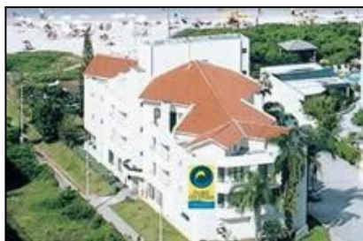
Foto 24: Visão geral do empreendimento
