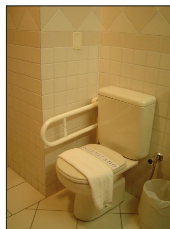
Foto 31: BWC em uma UH adaptada para portadores de deficiência sem parte de exigências da NBR 9.050/04 – Hotel da Praia
