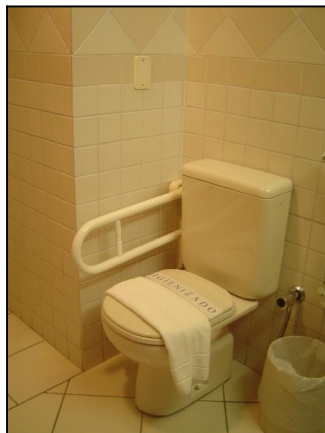
Foto – Uso de caixas acopladas 6 litros nos BWC das UH'S.
