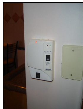
Foto – sistema de economia energético Stop Light presente nas UH'S.
