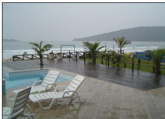
Foto – área para infiltração de água no terreno é menor que 30% da área total.
