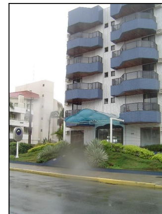
Foto – detalhe do envelope construtivo e entrada sem a presença de rampas de acessibilidade.
