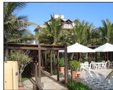
Foto 14: Visão ao fundo da edificação principal a partir do jardim e piscinas.
