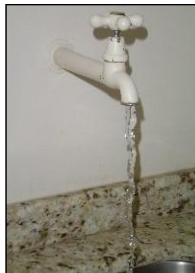
Fotos 37 e 38: BWC social sem uso de vasos com caixa acoplada 6 litros. Torneira da cozinha das UH'S sem arejadores. Consumo alto. – Praiatur All Suítes
