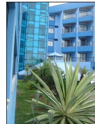
Foto – UH'S e suas janelas em alumínio e vidro sem venezianas para melhor entrada de ar e detalhe na Foto 00 mostrando a cobertura da área social com jardins suspensos e ajardinados.
