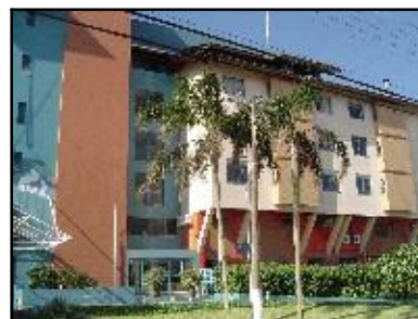
Foto - envelope construtivo, possui um sistema de fechamento opaco com detalhes em cerâmicas. Cores claras.
