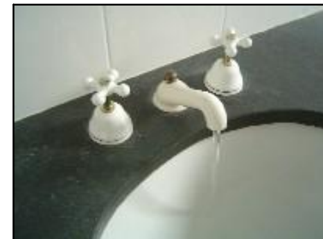
Foto – vasos sem caixas acopladas e torneiras dos lavatórios sem arejadores.
