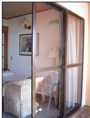
Foto - UH'S e seu sistemas de fechamento com alumínio e vidro.
