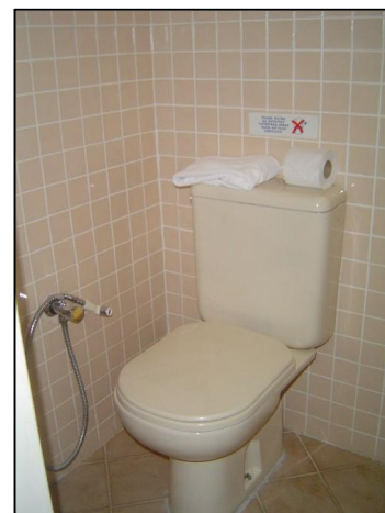
Foto 36: Utilização de caixas acopladas 6 litros em todas as UH'S do empreendimento – Ingleses Praia Hotel
