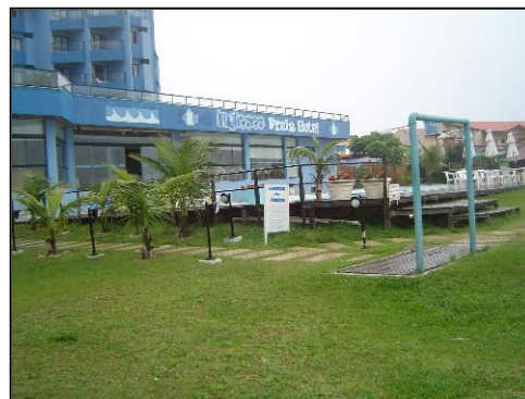
Foto 29: Topografia com a presença de garagem no subsolo e hotel mais alto que o nível natural do terreno – Ingleses Praia Hotel
