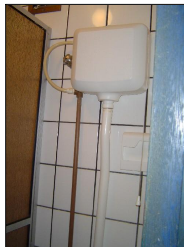
Foto – Caixa de PVC 3 litros – presente nos banheiros dos funcionários na parte de serviço.
