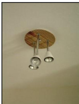
Foto – Iluminação das UH'S com lâmpadas PAR.
