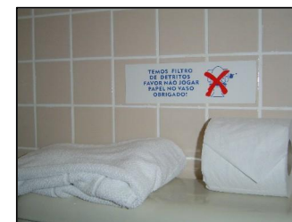
Foto - detalhe do adesivo colado sobre as caixas acopladas das UH'S informando a existência de filtros de detritos.
