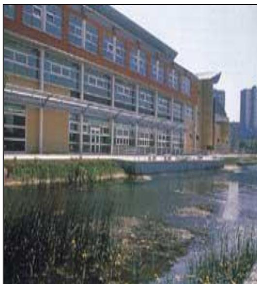
Foto 07: Vista lateral do fosso ao redor da edificação para ajudar na suavidade do clima da região no verão. FONTE: Arquitetura Ecológica pg. 199
