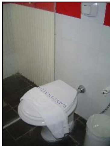
Foto – vasos sem caixas acopladas e torneiras dos lavatórios sem arejadores.
