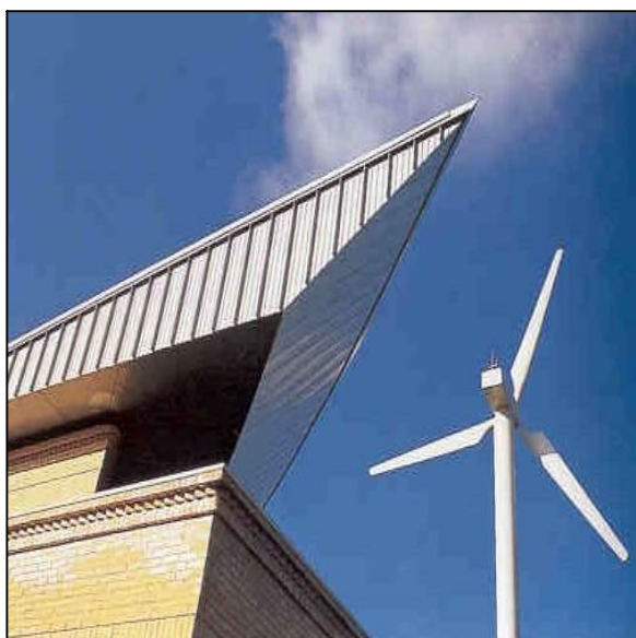
Foto 06: Moinho eólico produz uma parte da eletricidade consumida pelo edifício. FONTE: Arquitetura Ecológica pg. 198
