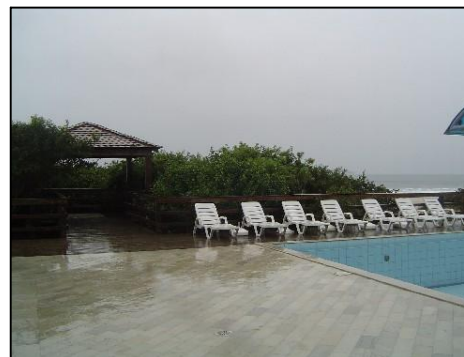
Foto – grande parte do terreno é edificado ou revestido impedindo a infiltração de águas da chuva.
