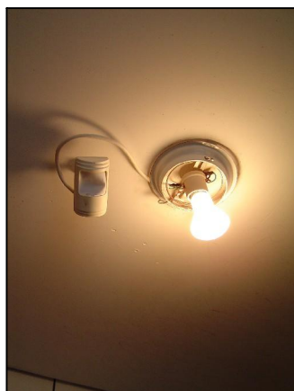
Foto – detalhe do aparelho de sistema de presença na parte de serviço, porém com lâmpada incandescente.
