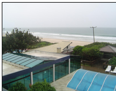
Foto 16: Vista da praia com o bloco da piscina térmica
