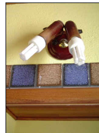
Foto – lâmpadas compactas fluorescentes nos banheiros das UH'S – uso de 100% delas nestas áreas.
