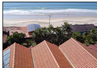
Foto - cobertura com telhas cerâmicas.
