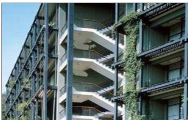
Foto 10: Relação interior / exterior – Detalhe das escadas abertas.
