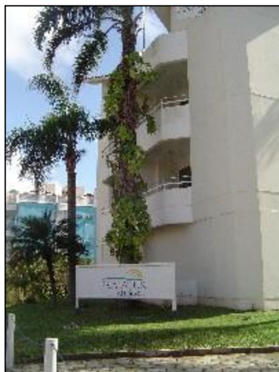
Foto – relação da implantação da edificação e topografia. Pouco movimento de terra.
