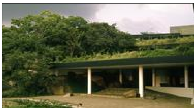
Foto 11: Coberturas ajardinadas – ajuda no resfriamento interno da edificação.
