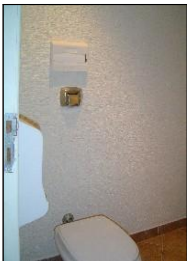
Fotos 37 e 38: BWC social sem uso de vasos com caixa acoplada 6 litros. Torneira da cozinha das UH'S sem arejadores. Consumo alto. – Praiatur All Suítes
