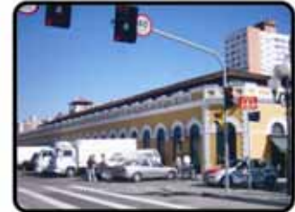
Foto 03 - Acesso por faixa de segurança.
