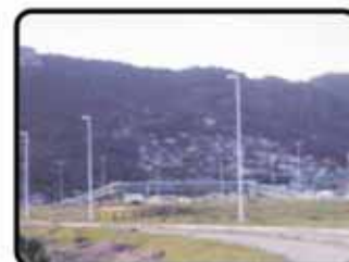
Foto 04 - Passarela para pedestres.
