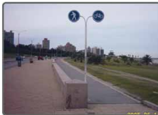
Figura 89 - Pista de caminhada e de ciclismo separadas por uma mureta. Fonte: Acervo Próprio
