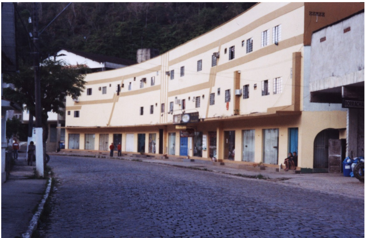
FIGURA 35 – Edifício Residencial – Antigo Centro Comercial Azambuja
