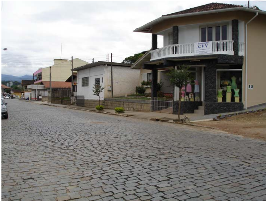
FIGURA 28 – Residência na Rua Azambuja com Loja no Piso Inferior
