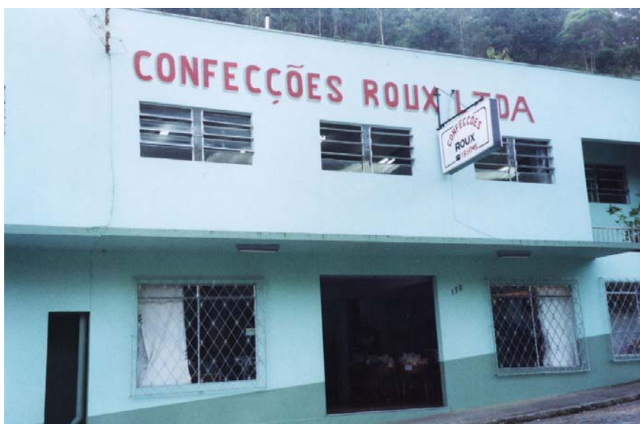
FIGURA 04 – Fachada da Confecção Roux
