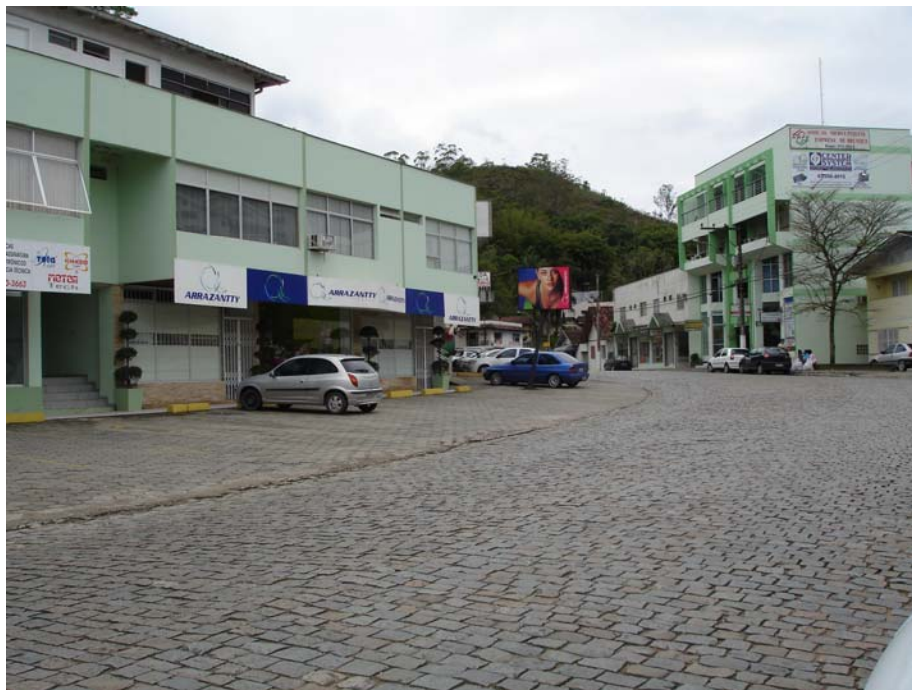
FIGURA 29 – Cento Comercial na Rua Azambuja (Construção Verde à Esq.)
