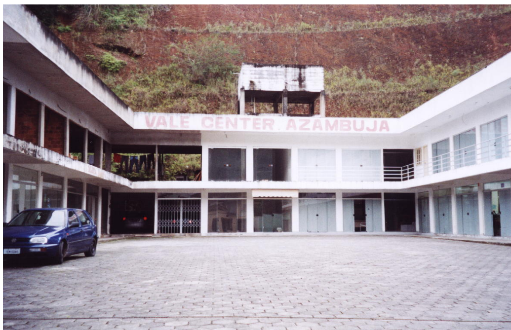
FIGURA 37 – Centro Comercial Vale Center Azambuja – Atualmente Está Abandonado
