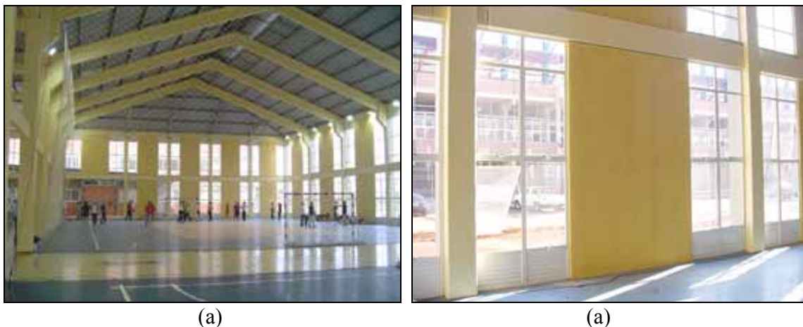
Figura 5.6 – (a) Vista interna do ginásio e (a) vista interna dos painéis sanduíche em GRC
