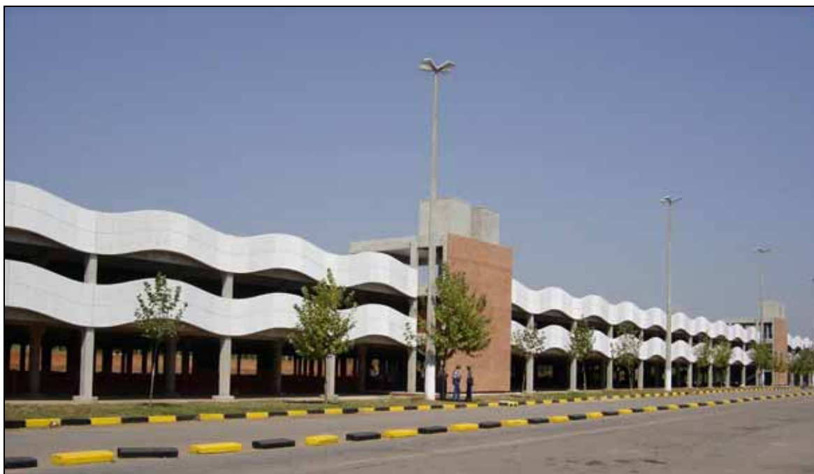
Figura 5.28 – Volumetria da fachada oeste mostrando os painéis em concreto armado revestidos com plaquetas cerâmicas e os painéis sinuosos em GRC na cor branca
