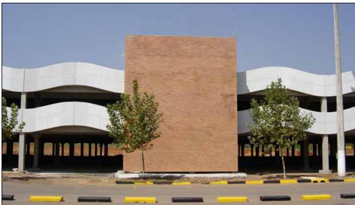
Figura 5.29 – Fachadas da caixa de escadas construída com painéis em concreto armado.
