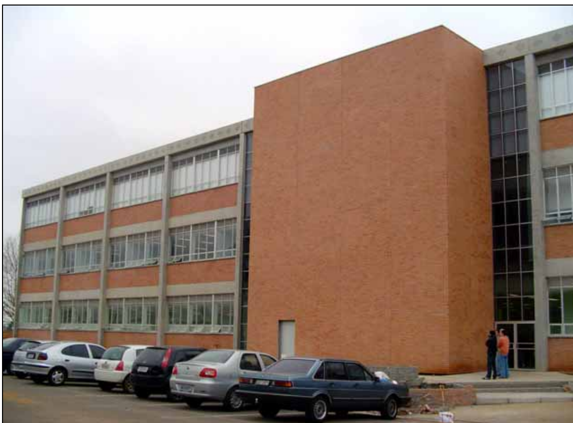
Figura 5.16 – Fachada leste com a escada enclausurada em destaque.
