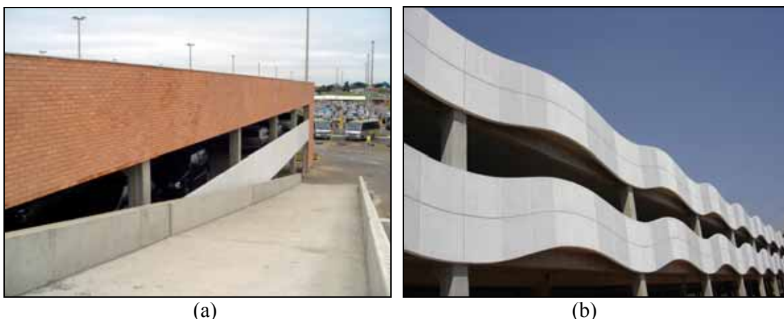
Figura 5.34 – Vista da (a) rampa de acesso da fachada Norte e (b) dos painéis sinuosos na fachada Oeste.
