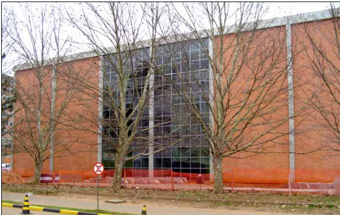
Figura 5.9 – Vista da fachada sul
