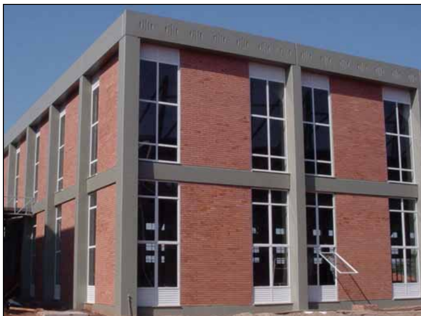
Figura 5.2 – Fachadas do ginásio esportivo com painéis pré-fabricados em GRC revestidos com plaquetas cerâmicas.
