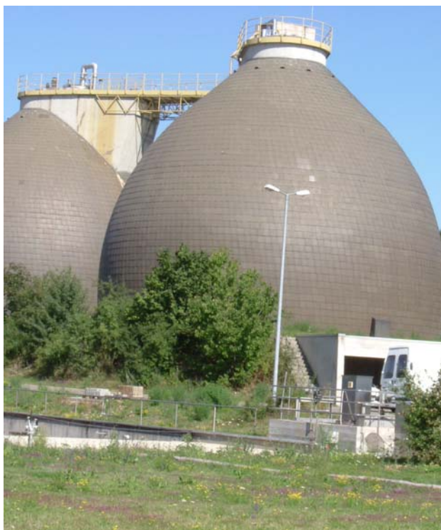
Figura 4.2. Estação de tratamento de esgotos de Theüern – Alemanha
