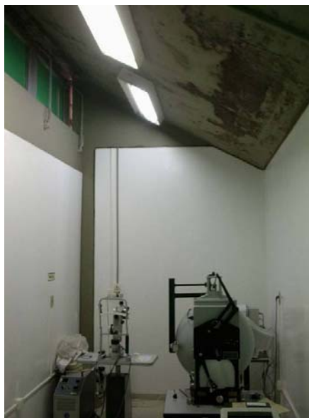
Figura 36 - Consultórios com dimensões insuficientes.
