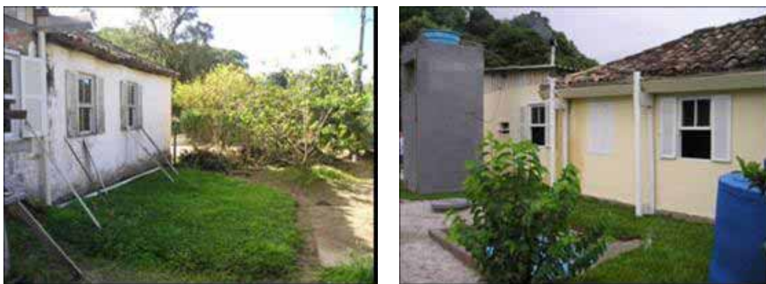
a) Antes da colocação das unidades.
