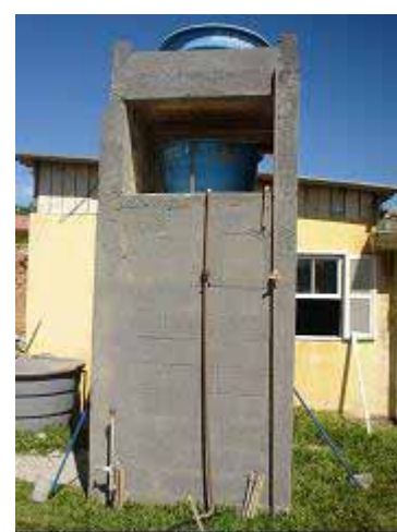
c) reservatório superior de reúso e reservatório de água potável.
