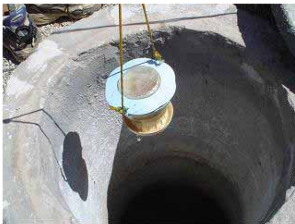
Figura 22: Desinfecção com pastilha de cloro.
