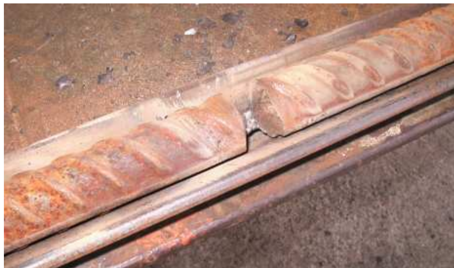
Figura 3.2.7 – Cantoneira utilizada como Dispositivo de Soldagem.
