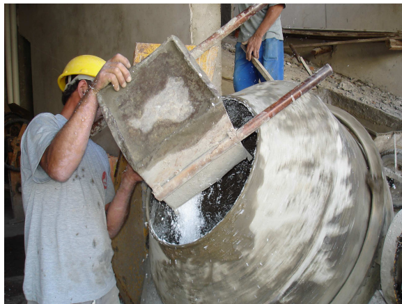
Figura 35 - Preparação de concreto leve de EPS em betoneira.
