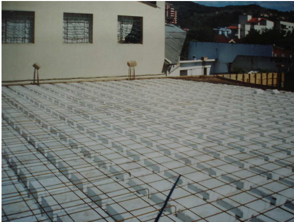
Figura 31c – Laje pré-fabricada bidirecional com emprego de blocos de EPS.
