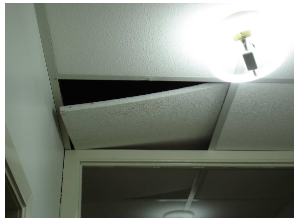
Figura 39 - Forro isolante e decorativo com o emprego de placas de EPS.
