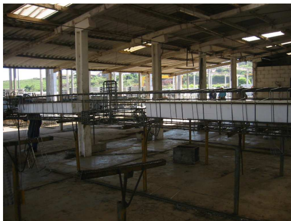
Figura 37 - Enchimento de elementos estruturais em EPS.
