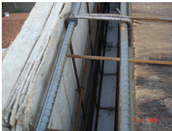
Figura 36 - EPS como fôrma de fundo de viga, sobre parede cega de alvenaria.
