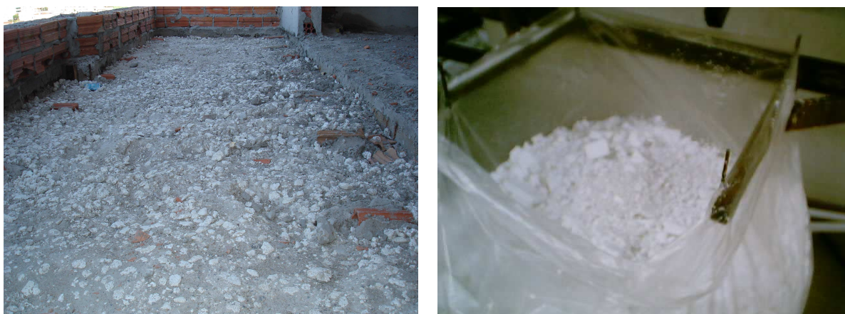
Figura 34 - Contrapiso executado com incorporação de resíduos de EPS.
