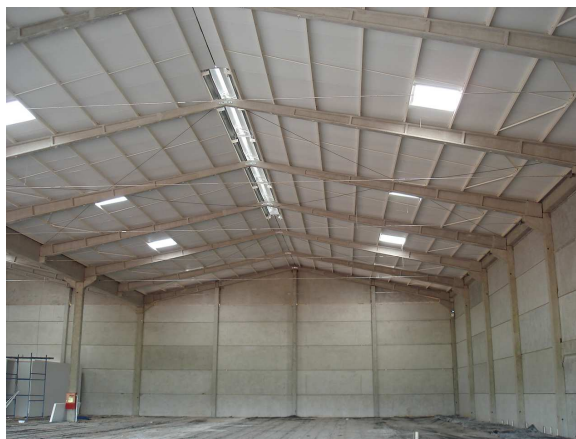
Figura 40 - Instalação industrial com isolamento de telhados e paredes.
