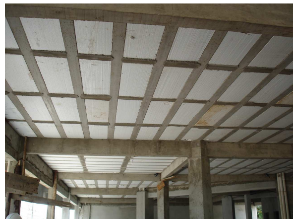
Figura 31b – Laje pré-fabricada unidirecional com emprego de blocos de EPS.
