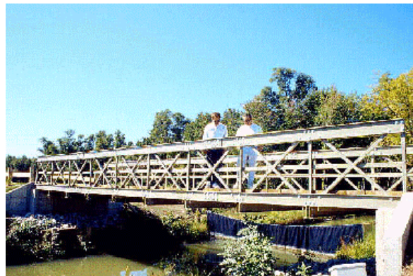
FIGURA 2.25 – Passarela Antioch Composite Pedestrian Bridge , localizada em Antioch, Illinois. Fonte: JOHANSEN (2003).
