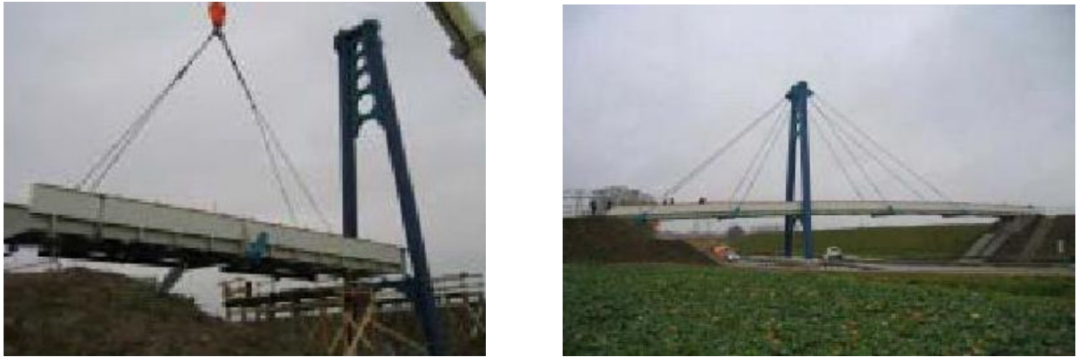
FIGURA 2.39 – Passarela Schwerin em fibra de vidro, construída na Alemanha. Fonte: CREATIVE PULTRUSIONS (2003b).
