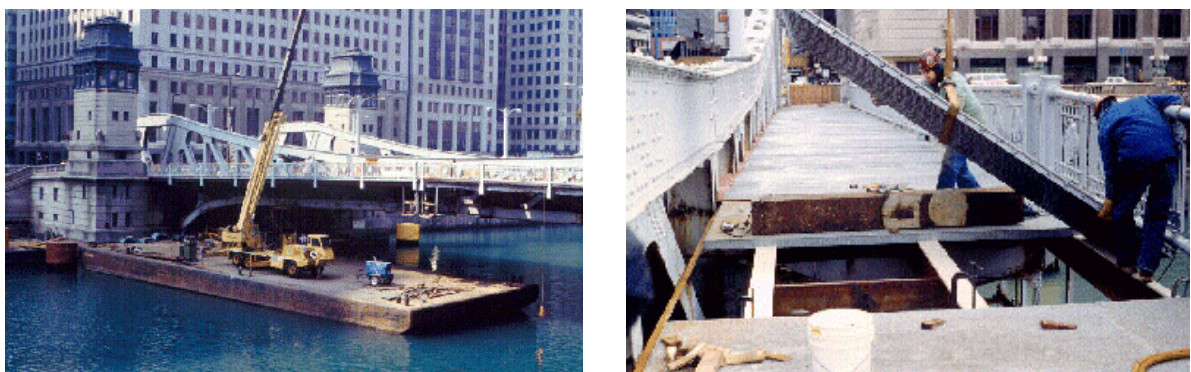
FIGURA 2.26 – Recuperação da LaSalle Street Bridge , sobre o Rio Chicago, na cidade de Chicago, Illinois. Fonte: MILKOVICH (2003).
