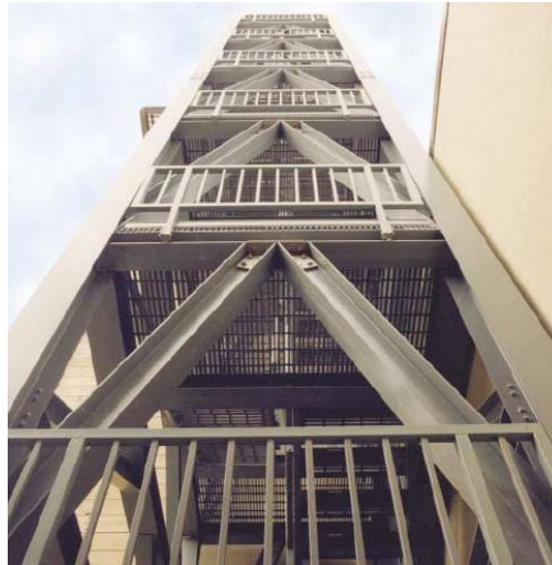
FIGURA 2.23 – Edificação para escadas construída em PRF. Fonte: STRONGWELL (2004).
