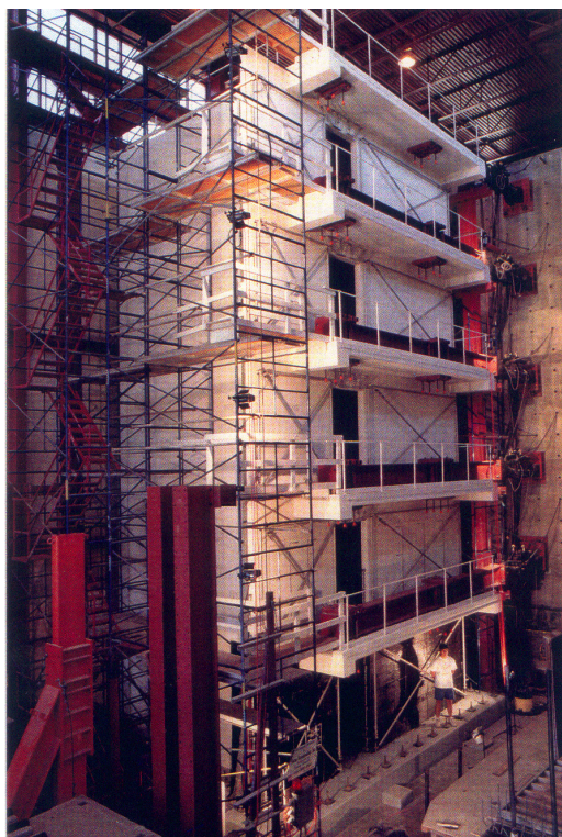
FIGURA 2.18 – Reforço efetuado no pavimento térreo, no edifício de 5 pavimentos. Fonte: SEIBLE et al. (1994).
