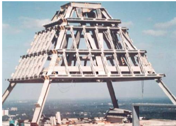
FIGURA 2.21 - Torre construída com PRF no Sun Bank Building . Fonte: STRONGWELL (2004).
