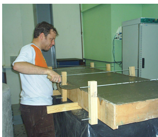
FIGURA 7.11 – Aplicação de uma camada de regularização de cimento e água na laje mista.
