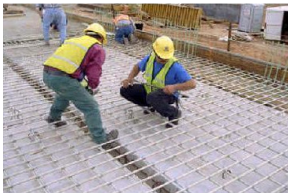
FIGURA 2.20 – Reforço interno de um tabuleiro de ponte sujeito a ciclos de degelo com sal. Fonte: MOSALLAM (2002).
