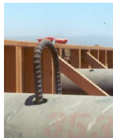
FIGURA 2.45 – Detalhe da conexão das vigas longarinas com o tabuleiro de PRFV. Fonte: ZHAO et al. (2001).
