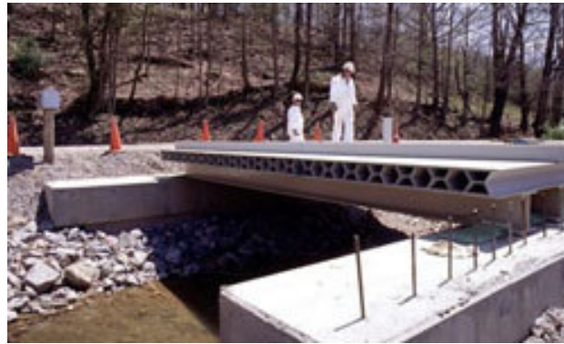
FIGURA 2.27 – Instalação da ponte em composto sobre o rio Laurel Lick . Fonte: OWENS CORNING (2003).
