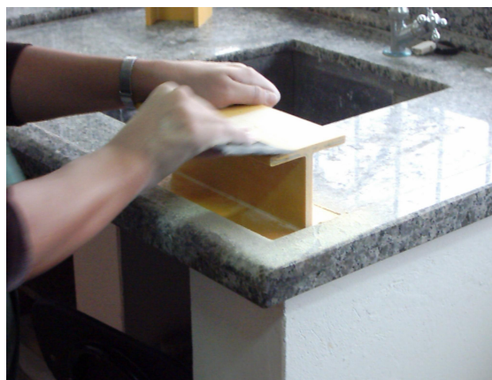
FIGURA 6.10 – Remoção da camada superficial de resina dos perfis de PRFV.
