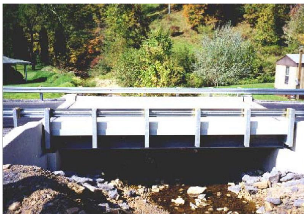
FIGURA 2.28 – Instalação da ponte em composto sobre o rio Wickwire run . Fonte: CREATIVE PULTRUSIONS (2003a).
