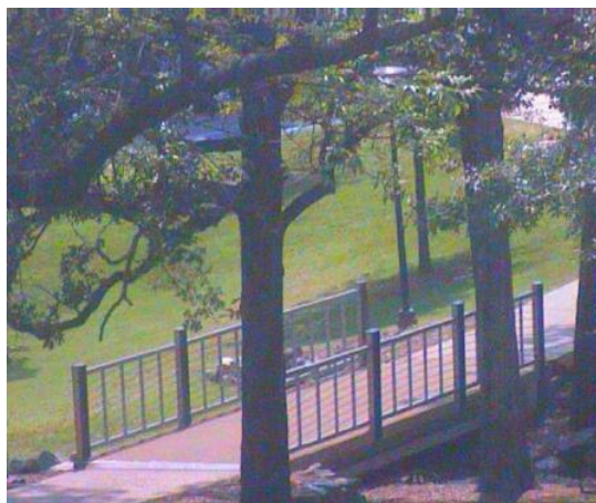
FIGURA 2.30 – Panorama da ponte instalada na UMR. Fonte: UNSER et al. (2000).
