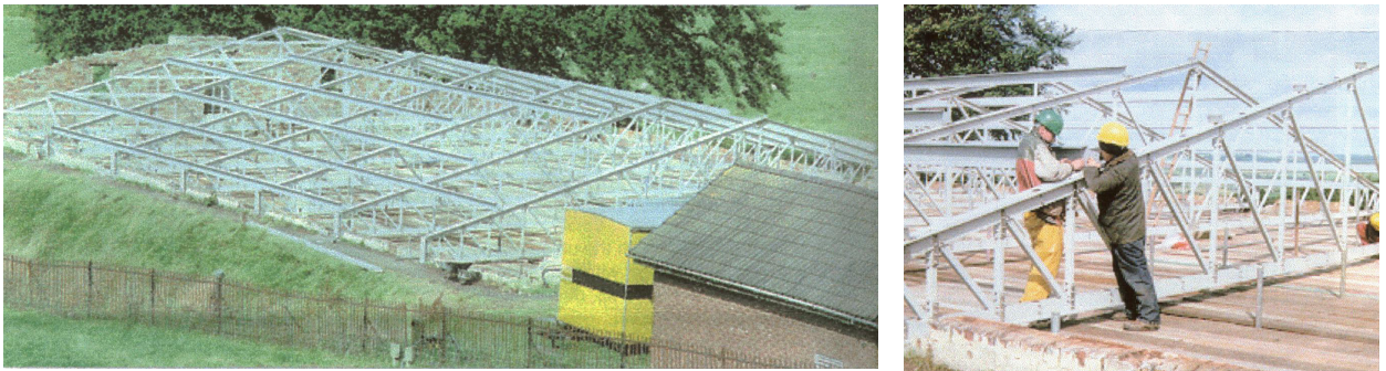
(a) (b) Figura 2.53 – (a) Panorama do pavilhão destinado à armazenagem de defensivos agrícolas; (b) detalhe da montagem do pavilhão. Fonte: EUZÉBIO (2004).
